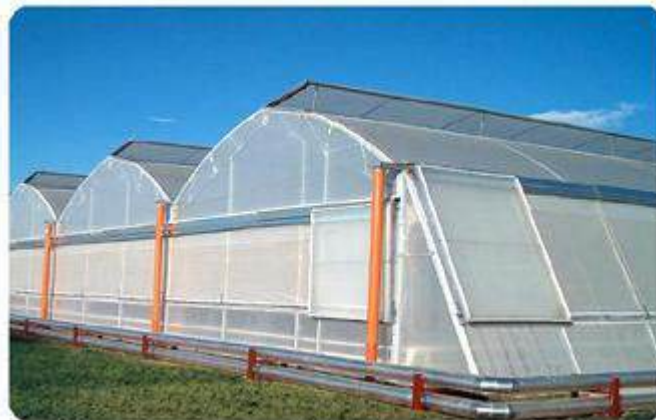
Figura 3. Invernadero en forma de Túnel
