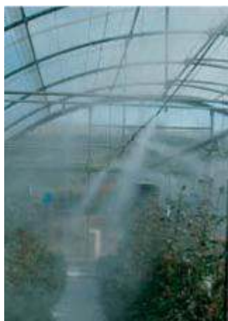
Figura 8. Sistemas de nebulización
