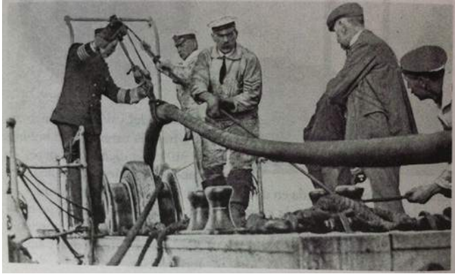
Instalación del cableado para la línea telefónica entre Inglaterra y Francia en 1910. El cable se tiende en el fondo marino del Canal de la Mancha.
