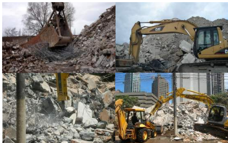
Figura 19 – Bolsas de demolição, caçambas dentadas puxam o aço, rompedores são usados para fragmentar o concreto armado, podem ser manuais ou acoplados em escavadeiras. Fonte: acima fotos de Sérgio C. ngulo [33], abaixo fotos de Carina Ulsen.
