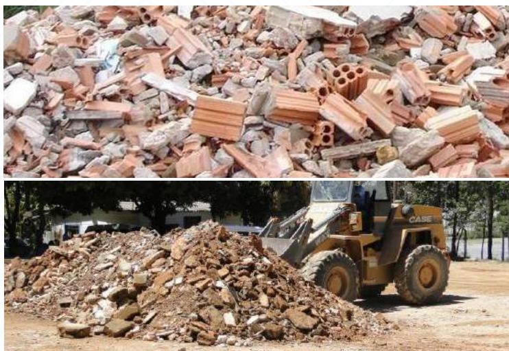
Figura 14 - Diferença entre resíduos de alvenaria contendo cerâmica vermelha (acima) do resíduo misto contaminado com solo (abaixo). Fonte das imagens: https://www.recicloteca.org.br/material-reciclavel/outras-pneu-e-entulho/attachment/lixo-entulhos-construcao/ / https://prefeitura.pbh.gov.br/noticias/bh-em-pauta-entulho-de-construcao-civil-e-reaproveitavel
