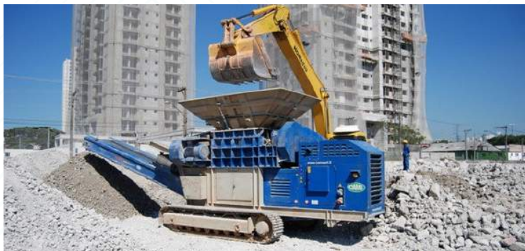
Figura 12 – Britagem de resíduo de concreto obtido em demolição seletiva, combinado com obra de construção próxima ao local. Fonte: Recinert Ambientale
