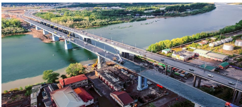
▲ Строительство мостового перехода через р. Белая в городе Уфа, полимерная гидроизоляция, износостойкое покрытие;
