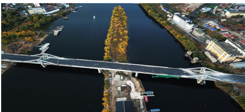
▲ Строительство мостового перехода "Фрунзенский" в городе Самара, полимерная гидроизоляция, износостойкое покрытие;
