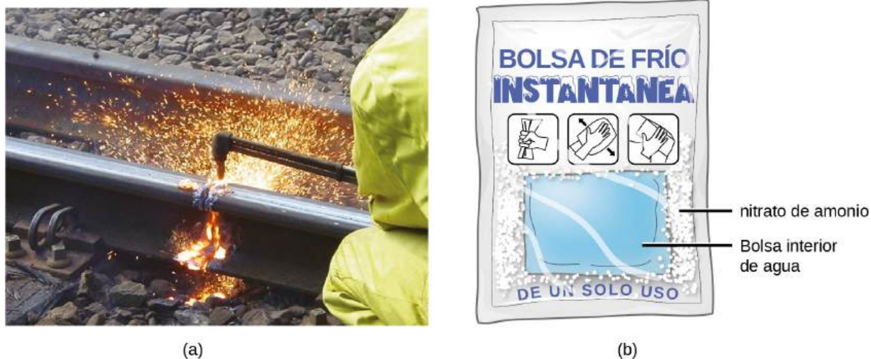
FIGURA 5.7 (a) Un soplete oxiacetilénico produce calor por la combustión de acetileno en oxígeno. La energía liberada por esta reacción exotérmica calienta y luego funde el metal que se corta. Las chispas son pequeños trozos del metal fundido que salen volando. (b) Una bolsa fría utiliza un proceso endotérmico para crear la sensación de frío (créditos a: modificación del trabajo de "Skatebiker"/Wikimedia commons).
