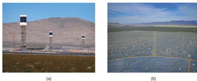
FIGURA 5.10 (a) La planta termosolar de Ivanpah utiliza 170.000 espejos para concentrar la luz solar en torres llenas de agua. (b) Cubre 4.000 acres de terreno público cerca del desierto de Mojave y de la frontera entre California y Nevada (créditos: a: modificación del trabajo de Craig Dietrich; b: modificación del trabajo de "USFWS Pacific Southwest Region"/Flickr).
