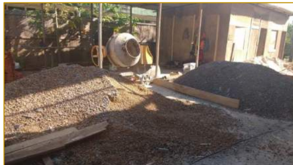
Figura 8. Betoneira não utilizada.
