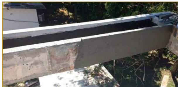
Figura 5. Visão inferior de uma viga com armadura exposta - patologia de concreto.
