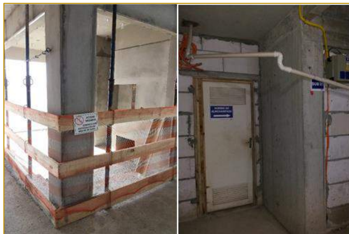
Figura 5 - Placa de acesso restrito (esquerda); Placa de acesso ao almoxarifado (direita).
