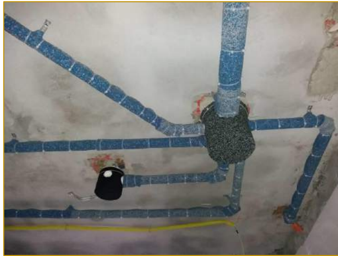
Figura 7 - Isolamento acústico de tubulações
