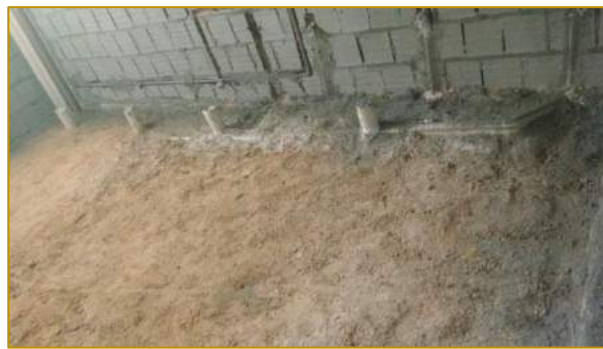
Figura 7. Rebaixamento das instalações hidráulicas.
