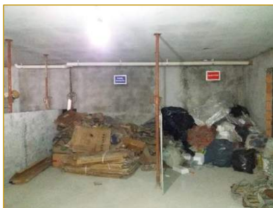
Figura 3 - Separação dos resíduos em baias sinalizadas
