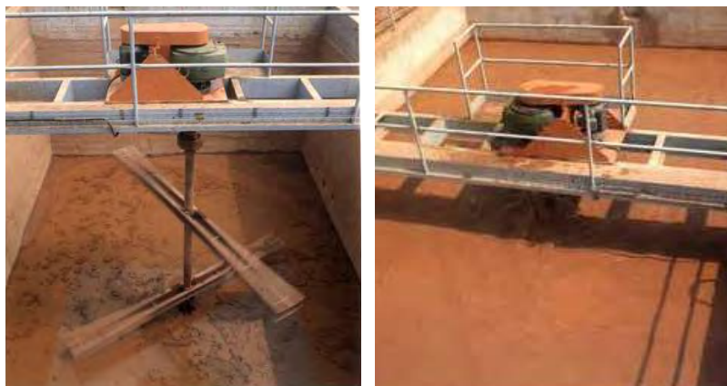
Figura 29 a y b. Agitador y balsa de homogeneización. [1]
