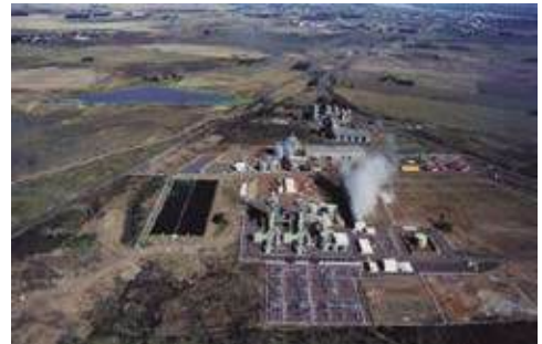
Foto 2 - Termoelétrica de Uruguaiana, RS
