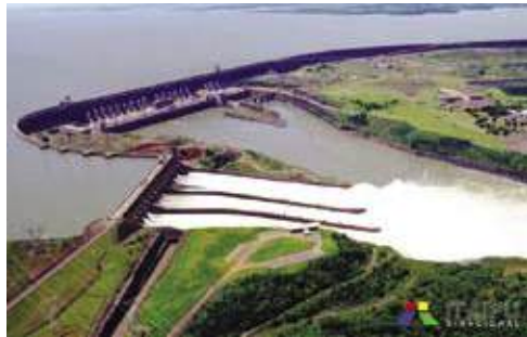
Foto 1 - Usina Hidrelétrica de Itaipu, PR
