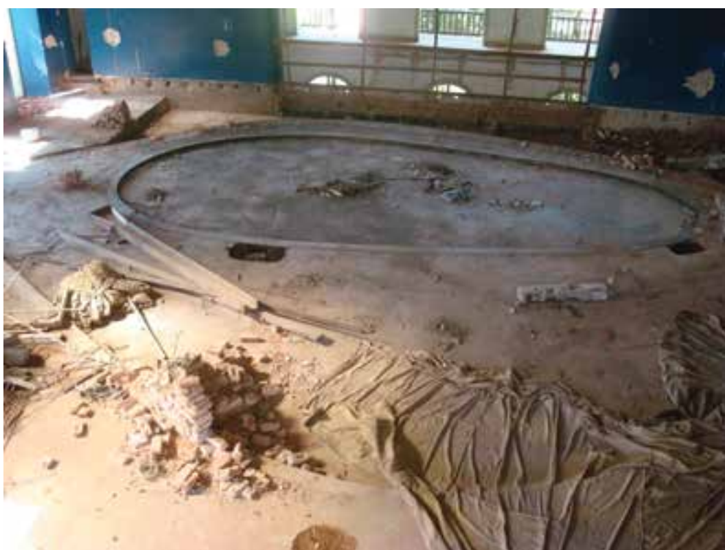
216-217 Boate Azul em processo de demolição: as paredes curvas, o bar e o palco já demolidos. Notar o desenho em granilite no interior do bar. Durante o processo de decisão entre a manutenção da Boate Azul e sua demolição, foi recomendada a proteção do piso da pista de dança: retiraram a cortina (que era em si um testemunho, ainda que da intervenção de 1992) e não protegeram o piso. Foto de 2011.
