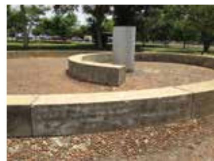
182-183 Notar o deslocamento dos módulos de concreto.
