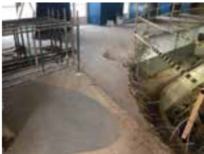
225-227 Boate Azul já demolida, sendo possível ver as frisas do antigo teatro sob a laje construída para o espaço.
