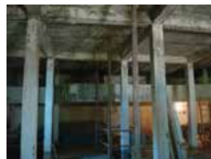
222-224 Boate Azul em processo de demolição: as paredes curvas, o bar e o forro já demolidos.
