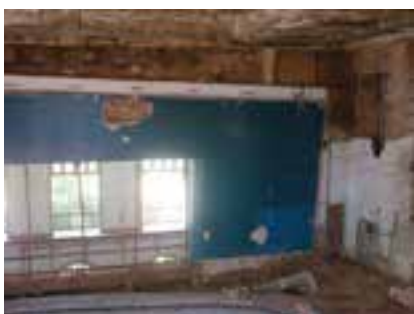
218-221 Boate Azul em processo de demolição: as paredes curvas, o bar, o palco e o forro já demolidos.
