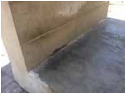
205-207 Notar a pintura sobre a estrutura em concreto aparente, apenas até a altura do segundo módulo da escultura.
