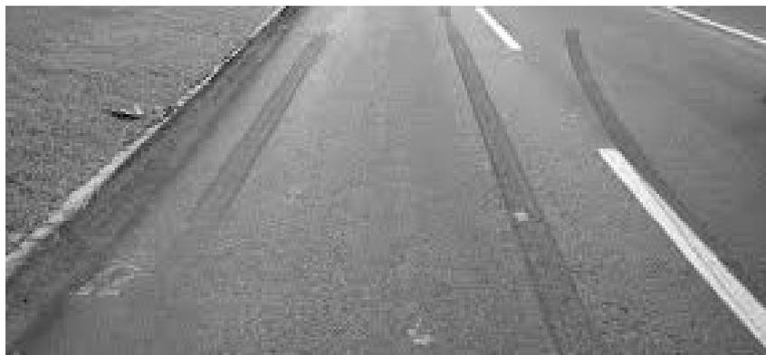
Figura 09- Marcas de frenagem no piso asfáltico
