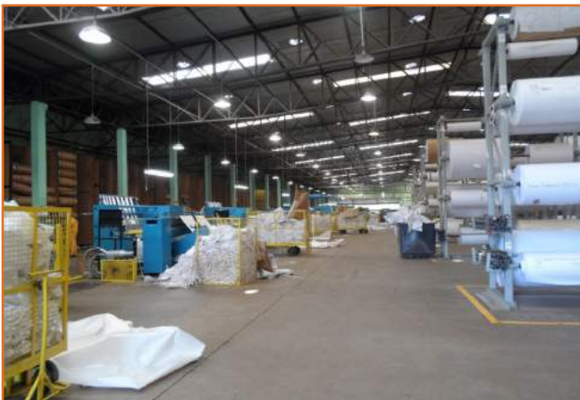
Figura 3 – Setor de Rebobinadeira
