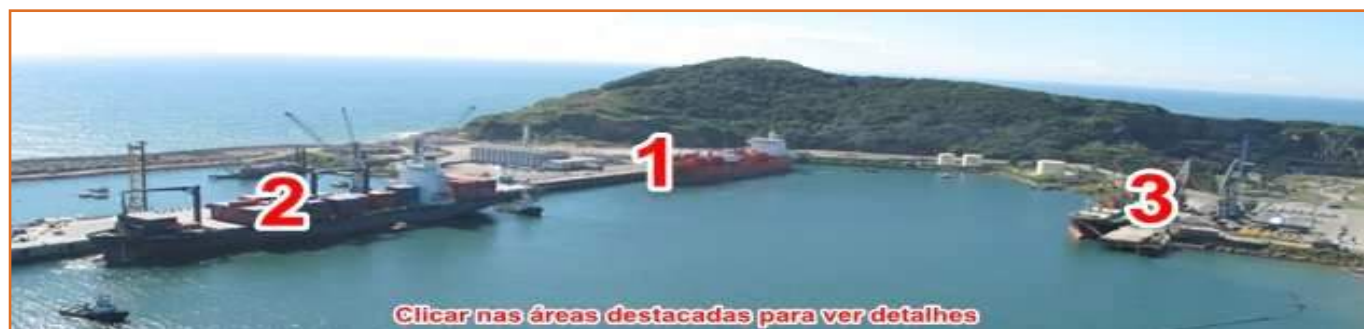
Figura 2- Berço de atracação Porto de Imbituba.
