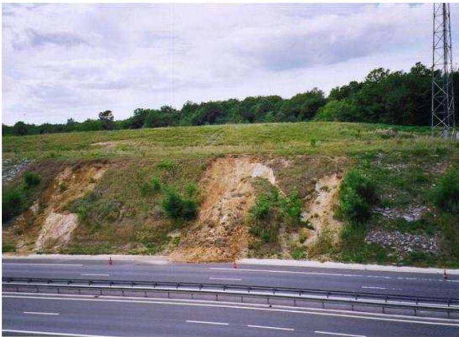
Glissements (petits) de talus d'autoroute
