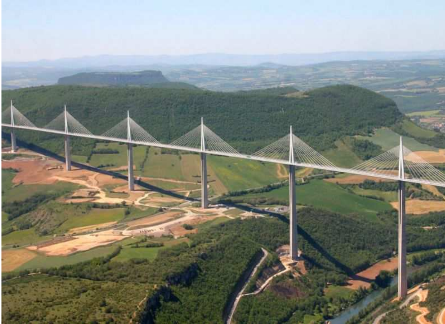
VIADUC DE MILLAU
