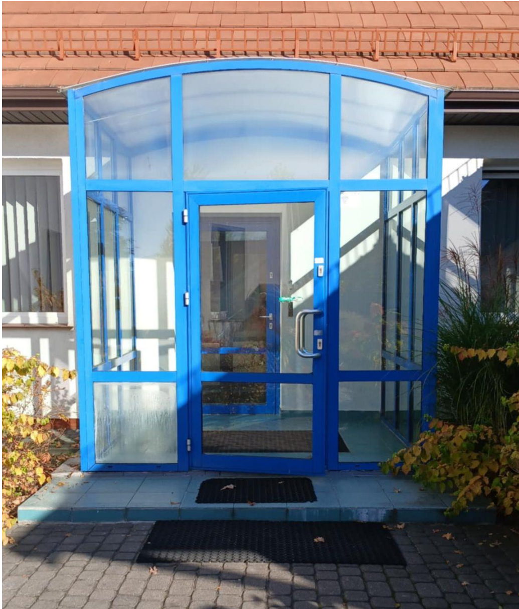
Istniejące wejście do budynku do demontażu
