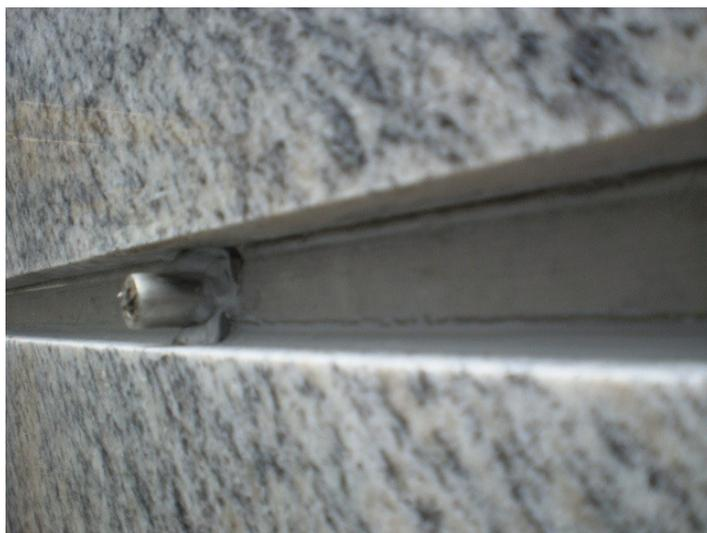
**Figura 4.22: Junta de 35 mm entre os módulos de granito com fixação do retentor do cabo para a fixação de equipamento de lava-fachadas**
