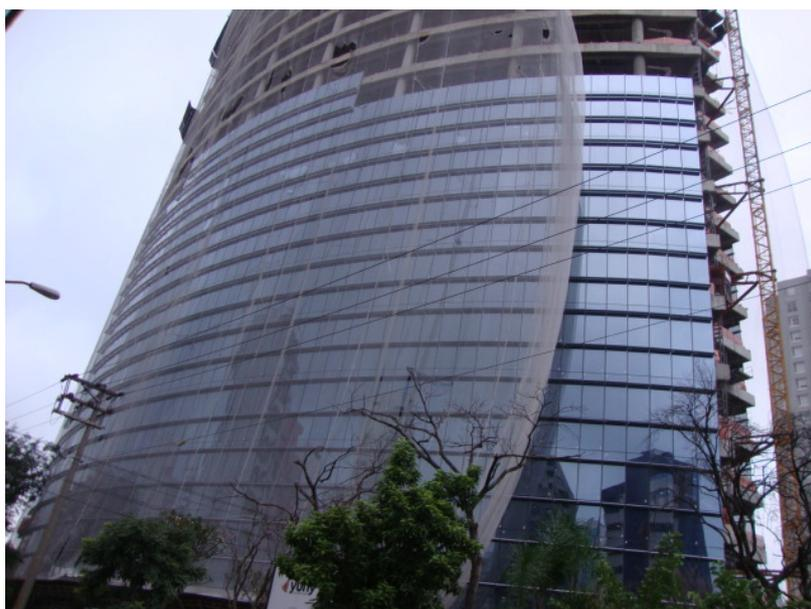
**Figura 4.90: Vista da fachada com aproximadamente 3/4 dos módulos instalados**
