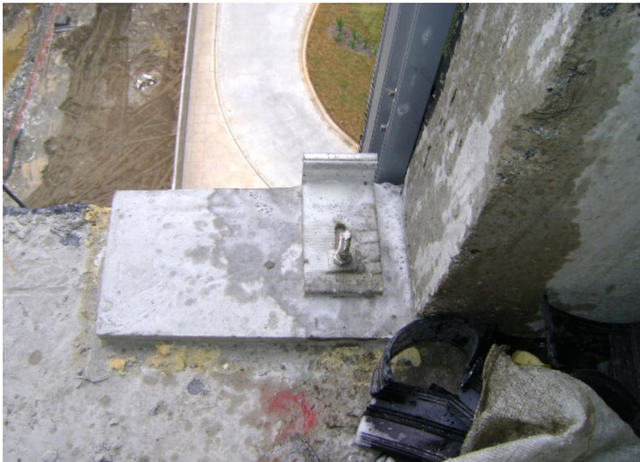
**Figura 4.35: Ancoragem do caixilho com alteração de posição ou altura do suporte**
