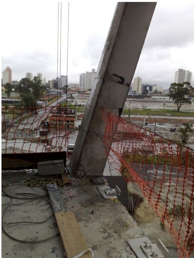
**Figura 4.36: Ancoragens da fachada inclinada (torre D)**
