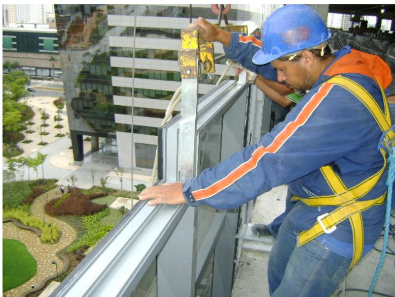
**Figura 4.52: encaixes para a fachada em pele de vidro**
