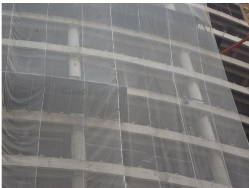
**Figura 4.80: Conclusão da estrutura de concreto**
