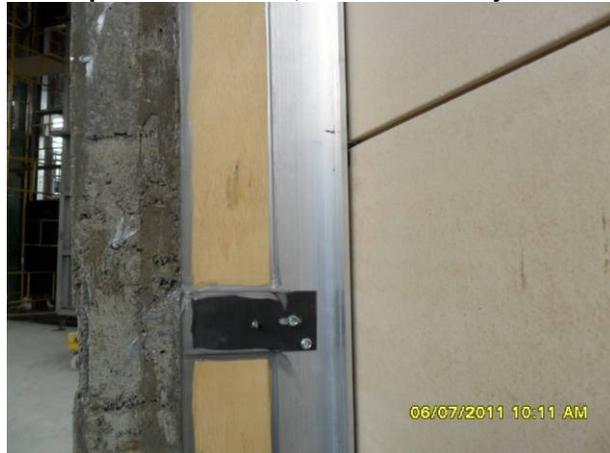
**Figura 4.129: Detalhes da subestrutura do *mock-up***
