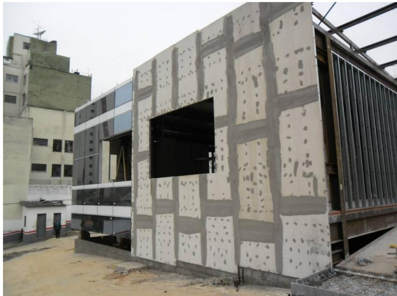
**Figura 4.148: Fachada unitizada e vedação em placa cimentícia para a área que receberá a fachada ventilada. Fonte: Foto tirada pela autora em agosto de 2011**
