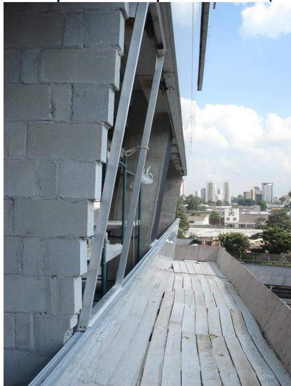
**Figura 4.43: Fachada inclinada caixilho entrevãos – instalação de contramarcos**
