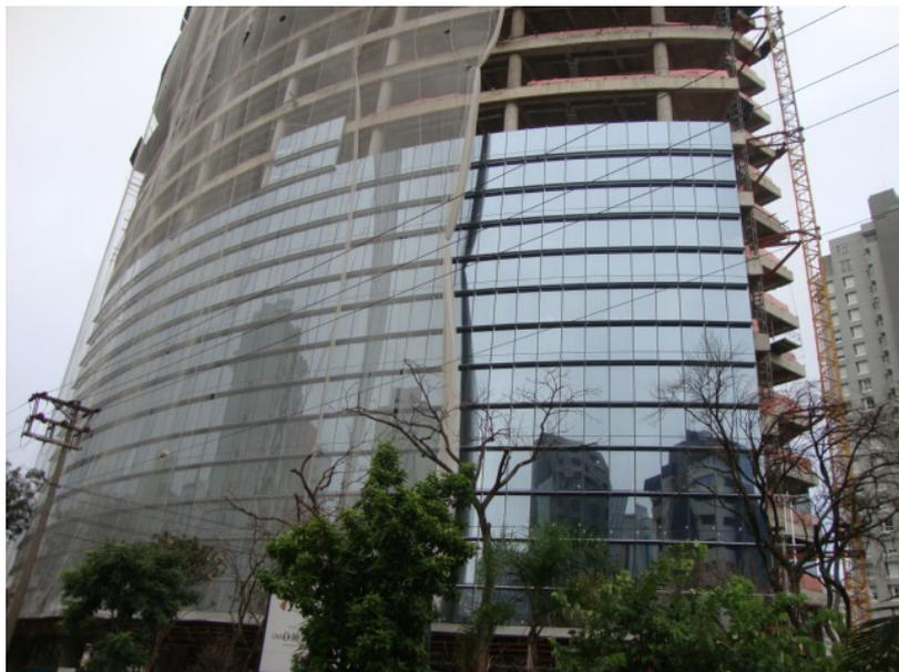
**Figura 4.88: Vista da fachada com aproximadamente 2/4 dos módulos instalados**
