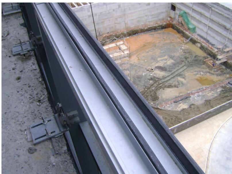
**Figura 4.54: Pele de vidro – para o encaixe do caixilho superior, outra borracha de vedação deve ser inserida. Fonte: Arquivos cedidos pela construtora (2008)**
