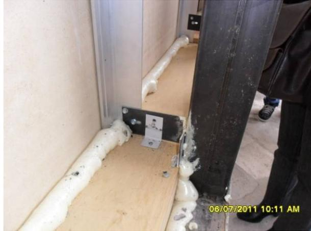
**Figura 4.128: Detalhes do painel de cerâmica extrudada instalado no *mock-up***
