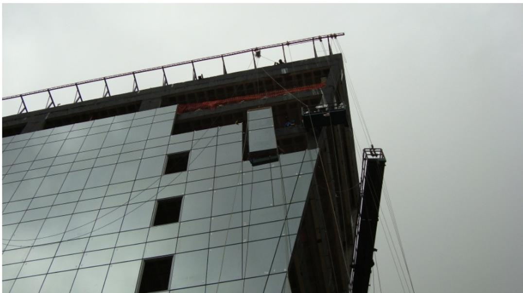
**Figura 4.51: Modulo unitizado sendo instalado na fachada (torre D) e balancim para instalação**
