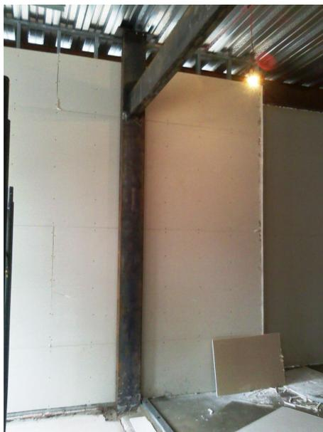
**Figura 4.151: Pilaretes 10 cm maiores que o especificado com a verga metálica**
