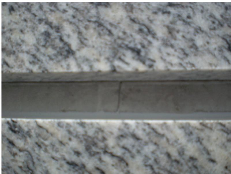
**Figura 4.20: Junta de 35 mm entre os módulos de granito**
