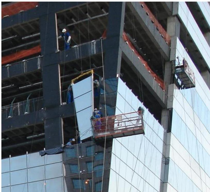
**Figura 2.21: Instalação dos módulos unitizados na fachada**
