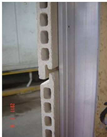
**Figura 4.127: Detalhes do painel de cerâmica extrudada instalado no *mock-up***
