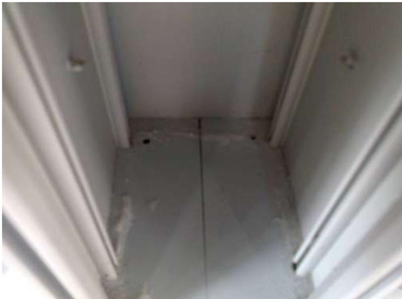
**Figura 4.100: Junção dos painéis sem luva e cantoneira vedação**
