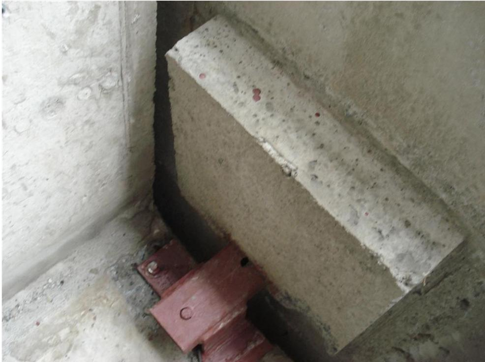
**Figura 4.61: Detalhe do apoio do painel de concreto sobre estrutura**
