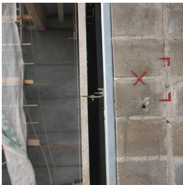
**Figura 2.29: Foto do sistema de fixação metálico na alvenaria de vedação**
