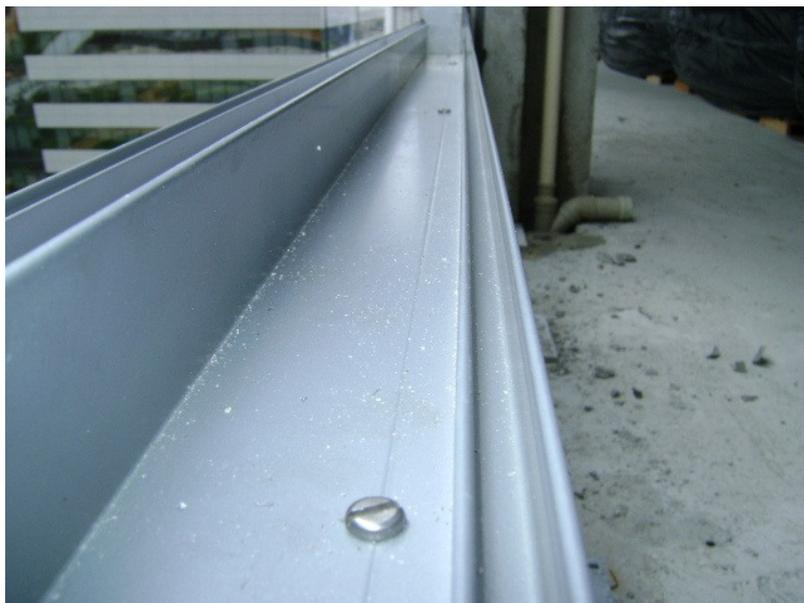
**Figura 4.55: Pele de vidro – cantoneira em alumínio acrescentada acima da borracha de vedação para fixação dos dois caixilhos**
