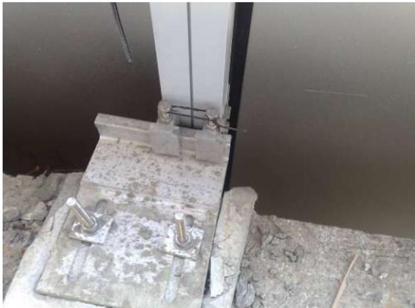
**Figura 4.96: Ancoragem desalinhada com suporte de fixação no canto da mesma**
