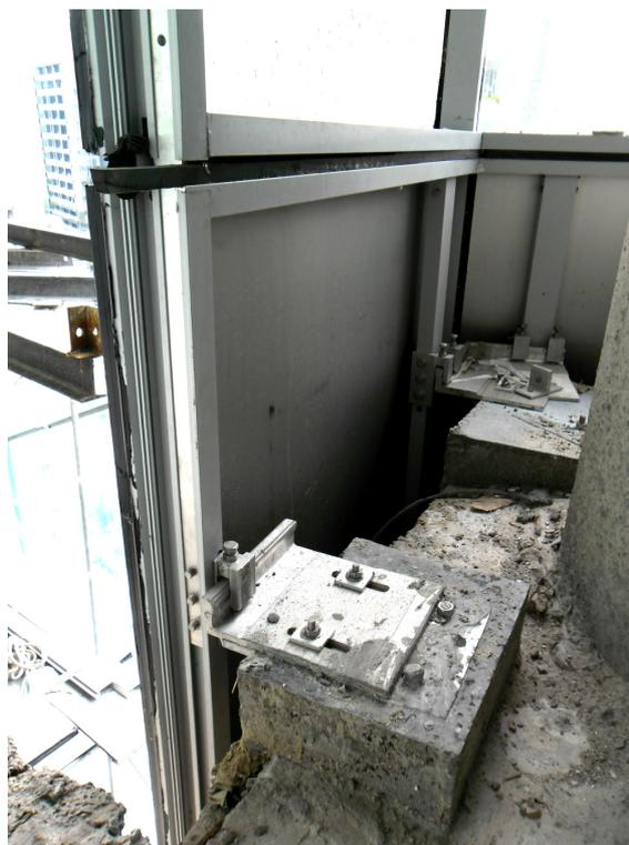
**Figura 4.85: Embutimento da ancoragem da estrutura no gancho de ancoragem do caixilho**
