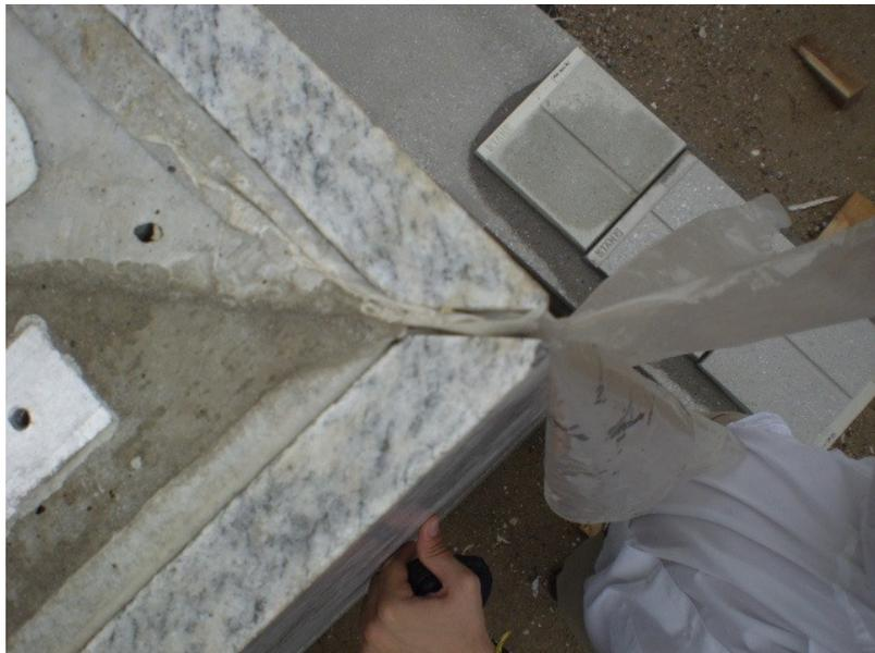
**Figura 4.21: Selamento das juntas entre painéis de concreto no canto**
