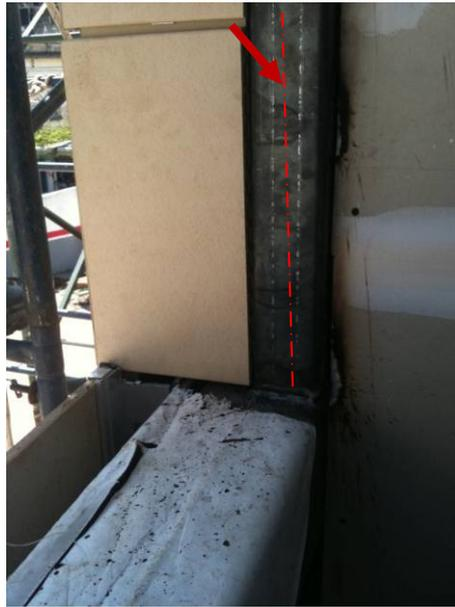
Figura 4.149: Vista da lateral da fachada ventilada com o pilarete de fixação do caixilho
