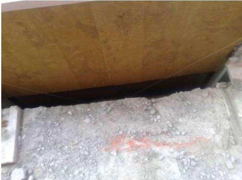
**Figura 4.98: Lã de rocha mal fixada**
