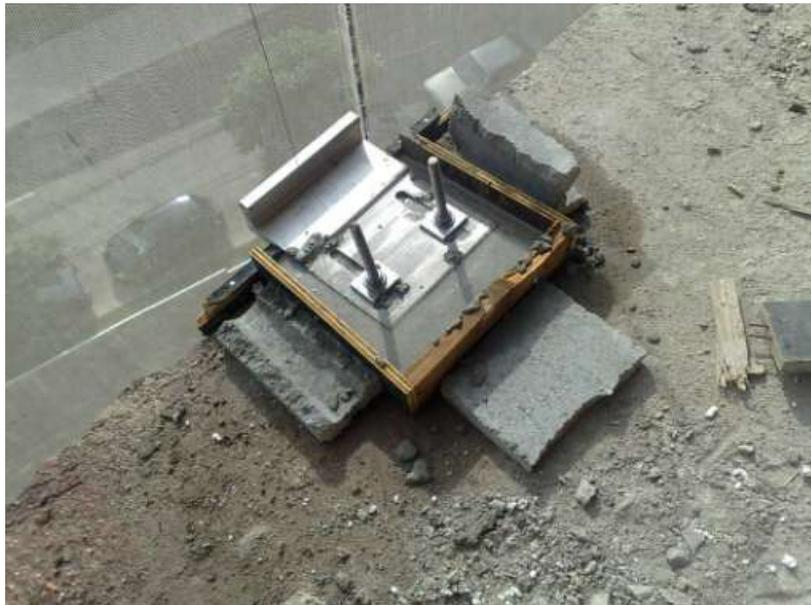
**Figura 4.94: Sapata feita com *grout***
