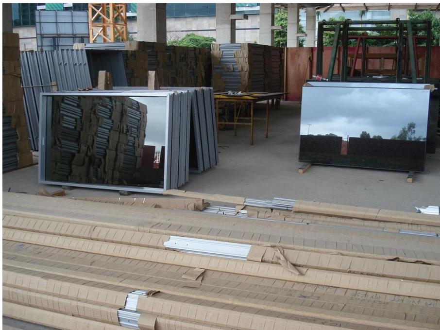
**Figura 4.32: Local de armazenamento dos vidros e caixilhos – torres A e B**
