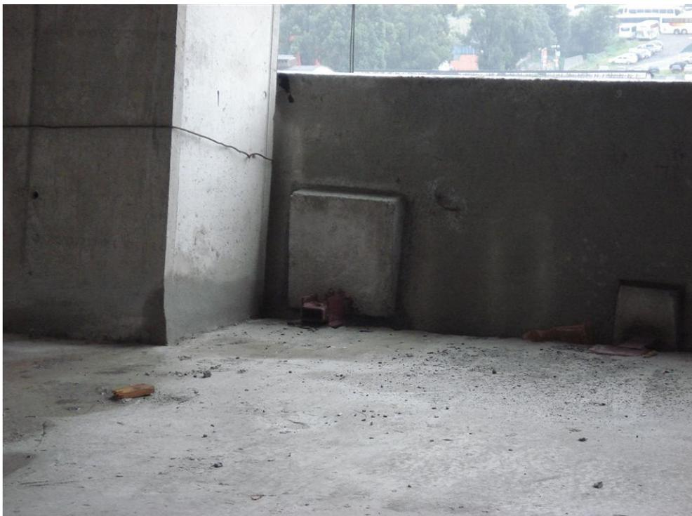
**Figura 4.62: Vista interna do painel de concreto pré-fabricado apoiado na estrutura**
