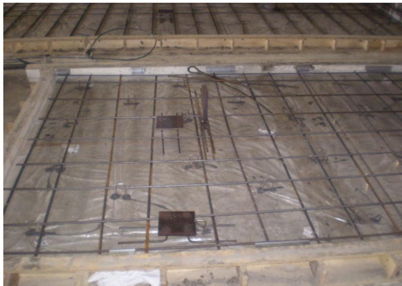
**Figura 4.17: Manta plástica colocada entre o concreto e a placa de granito, com o objetivo de evitar o contato entre os dois**
