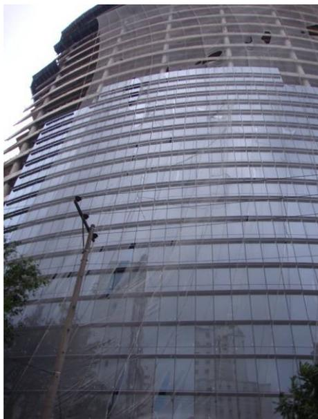
**Figura 4.89: Vista da fachada com aproximadamente 3/4 dos módulos instalados**
