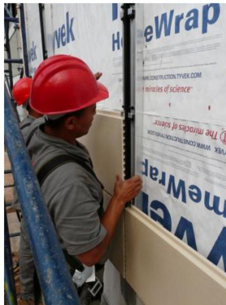
**Figura 4.154: Instalação da cerâmica extrudada na subestrutura e, sob ela, a manta Tyvek**
