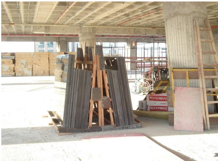
**Figura 4.30: Vidros em cavaletes adequados para transporte – torres A e B**
