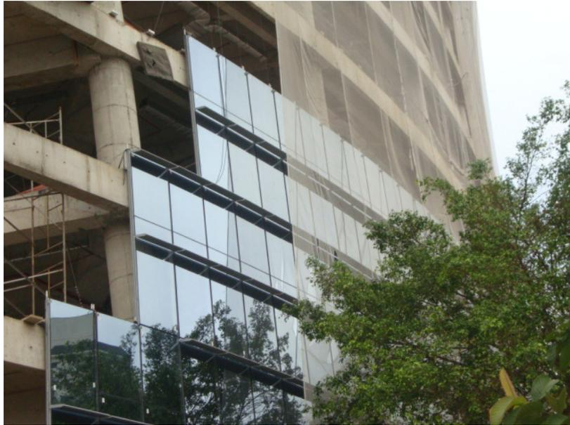
**Figura 4.83: Vista da fachada com andamento da colocação dos módulos**
