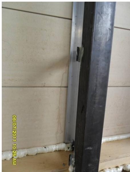
**Figura 4.141: Comportamento das placas cerâmicas quanto à estanqueidade sem carga de vento. Fonte: Arquivos da autora, foto tirada em julho de 2011**
