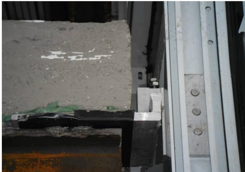
**Figura 4.146: Ancoragem da fachada instalada na mesa superior da viga metálica e groutada** Fonte: Foto tirada pela autora em agosto de 2011
