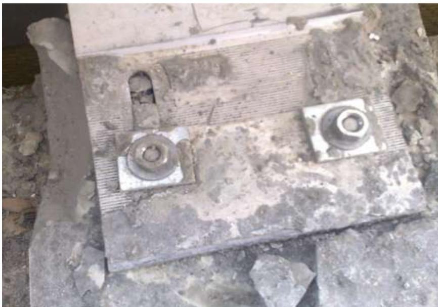
**Figura 4.103: Ancoragem com parafuso de fixação curto que deve ser substituído ou soldado na porca. Fonte: Arquivos cedidos pela construtora (fevereiro de 2011)**
