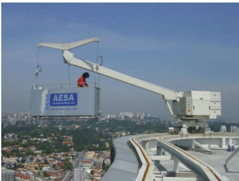
**Figura 4.26: Gôndola lava-fachadas instalado na cobertura das torres A e B em movimento**
