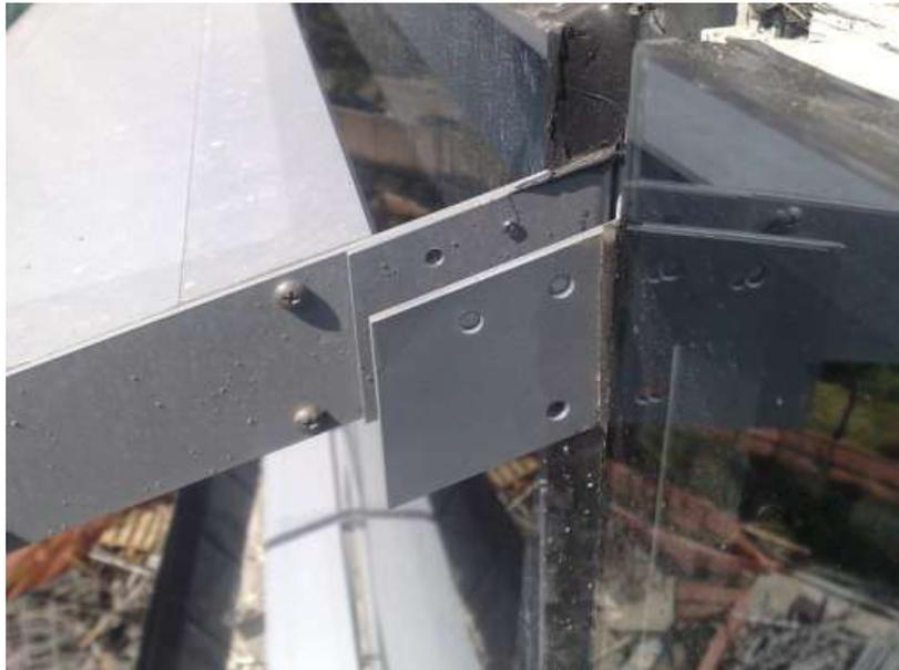
**Figura 4.105: Suporte de fixação dos *brises* nos painéis de canto fora de prumo com referência aos já instalados**
