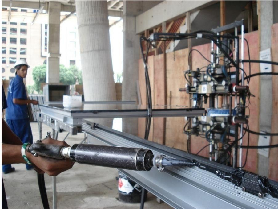
**Figura 4.38: Processo de colagem – aplicação de silicone**
