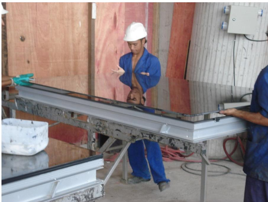
**Figura 4.37: Processo de colagem – posicionamento do vidro**
