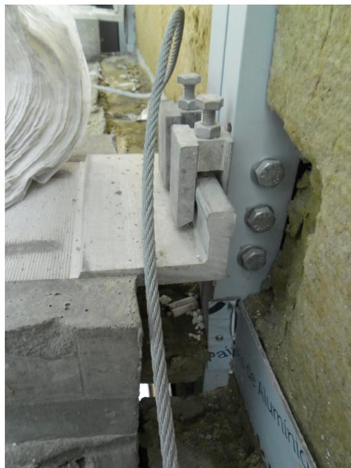
**Figura 4.82: Vista ampliada da ancoragem**
