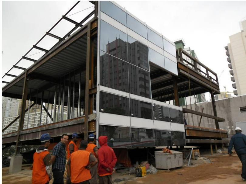
**Figura 4.147: Vista da fachada em sistema unitizado**
