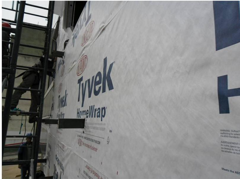
**Figura 4.155: Manta Tyvek com a subestrutura perfurando-a**
