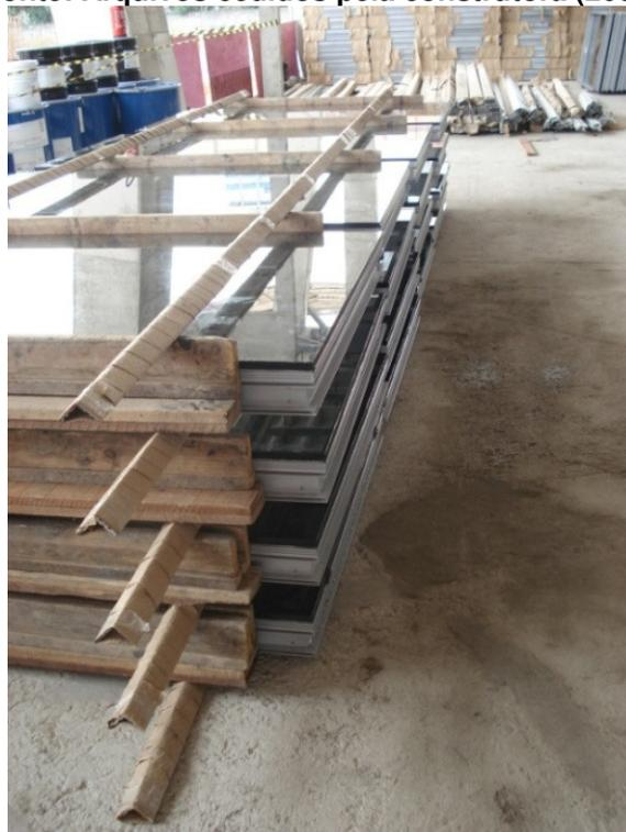
**Figura 4.41: Processo de colagem – esquadrias prontas para serem instaladas**
