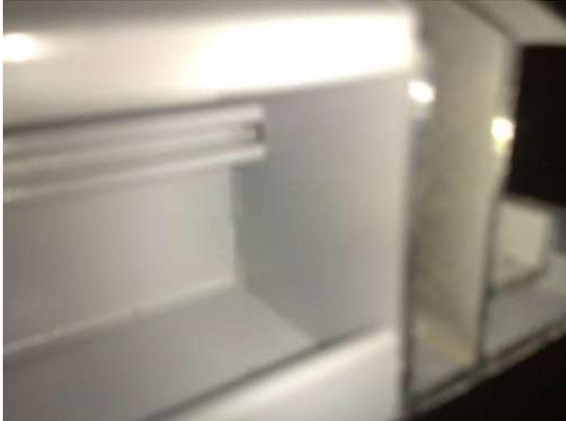
**Figura 4.99: Junção dos perfis painel sem vedação**
