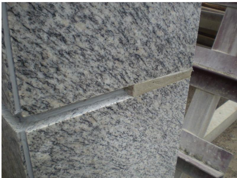
**Figura 4.19:** “Tira” de concreto preenchendo a junta no trecho do encontro do granito com o caixilho unitizado. Fonte: Arquivos da autora, fotos tiradas em setembro de 2009
