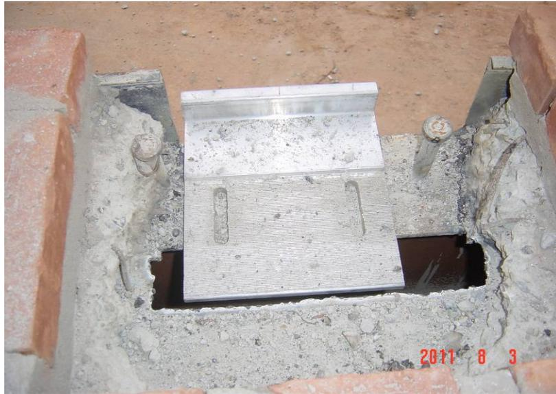
**Figura 4.145: Ancoragem instalada nos nichos do *steel deck***
