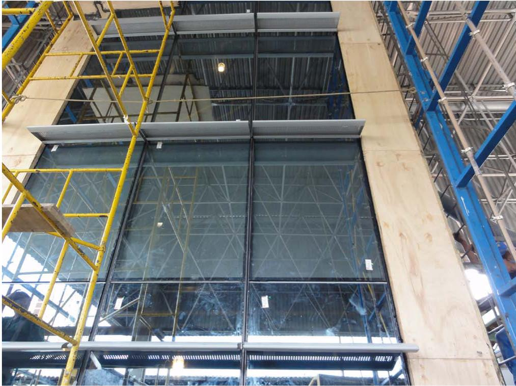
Figura 4.76: *Mock-up* da fachada-cortina em sistema unitizado montado para ser ensaiado no ITEC. Fonte: Arquivos cedidos pela construtora (dezembro de 2010)
