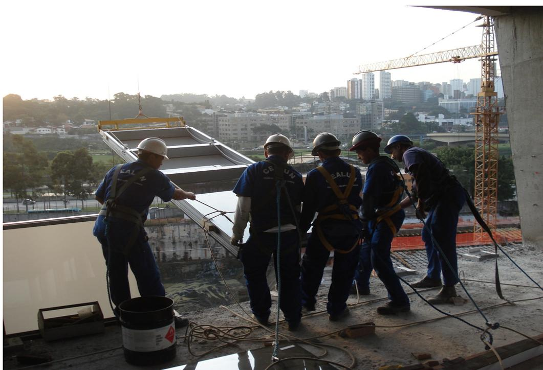
**Figura 4.50: O caixilho foi suspenso por um motor elétrico, e colocado próximo à posição de encaixe. Fonte: Arquivos da autora, fotos tiradas em setembro de 2009**
