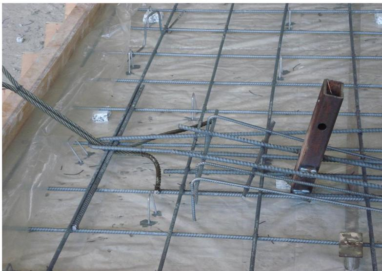
**Figura 4.18: Armação dos insertos no painel de concreto**
