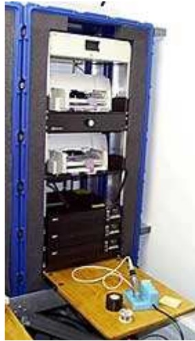
Estante de la UPS y de la impresora con las impresoras de la inyección de tinta y respaldo de la energía del VA 3000.
