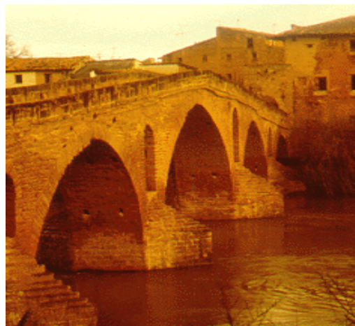
Puente románico de Gares (Navarra, siglo XI)
