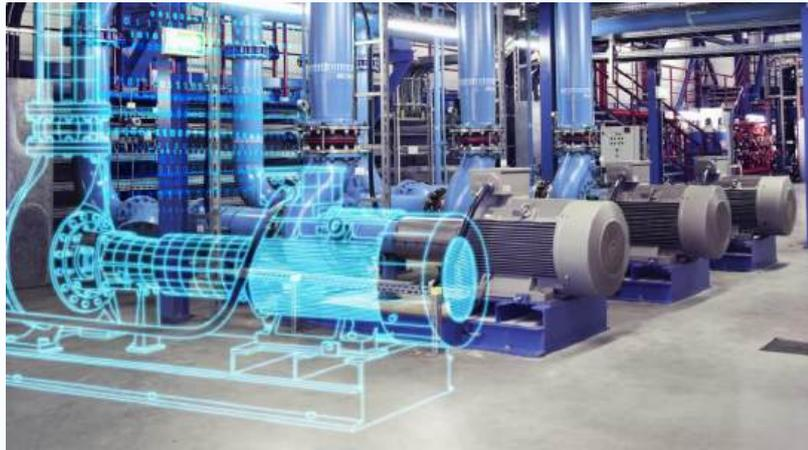
Figura 23. Representación gráfica de un gemelo digital para una bomba centrífuga
