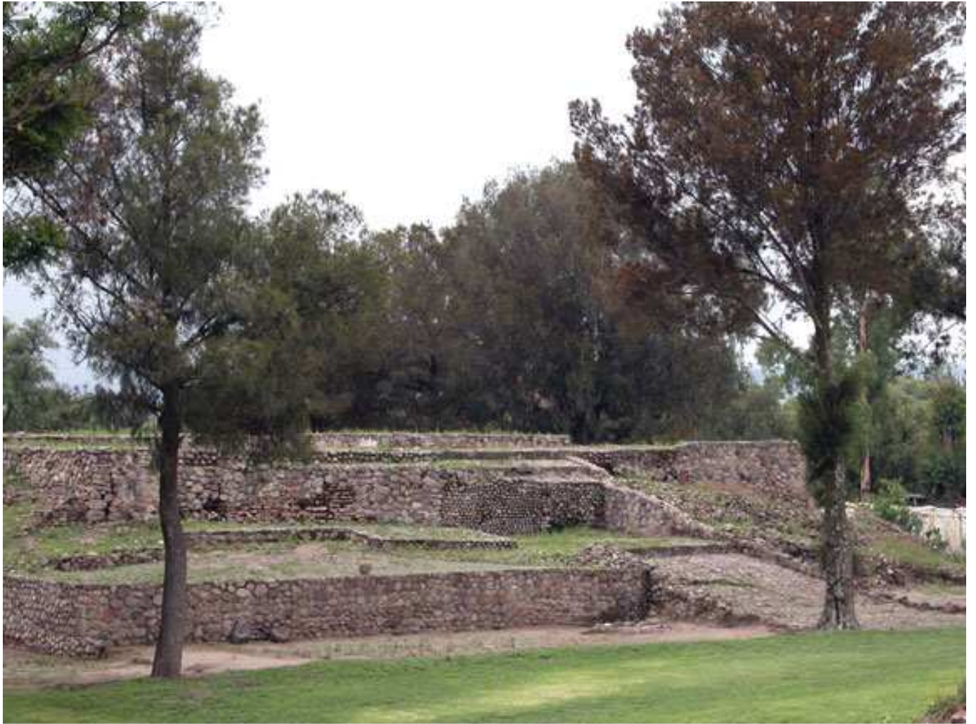
Figure 149. La Comunidad Building in Huexotla (photo Fernando González y González).
