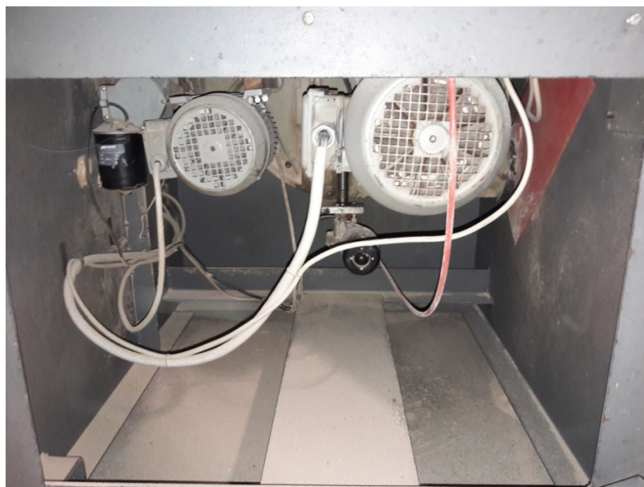
Figura 22 – Esquadrejadora após limpeza geral
