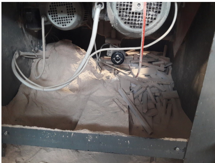
Figura 21 – Esquadrejadora antes da limpeza geral
