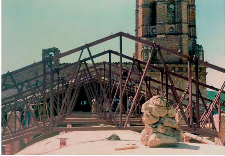
fig. 6. Intervenciones en la cubierta (fot. Servicio de Restauración, DPZ).
