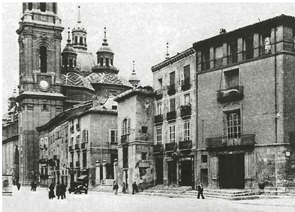
fig. 6. Vista de la fachada principal a la calle del Pilar de la casa del Marqués de Ayerbe. La fotografía está tomada una vez que había sido derribado ya el lado de los pares de la misma calle y había de procederse a su demolición en fechas inmediatas.
