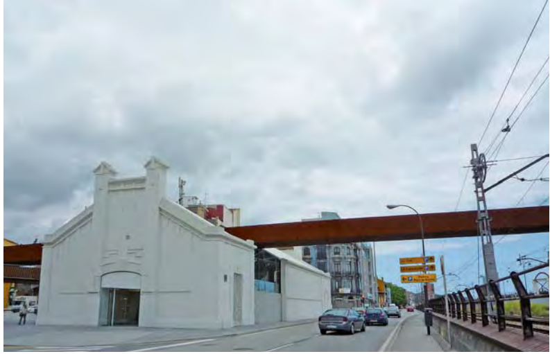
fig. 2. Edificio de la antigua Pescadería atravesado por la pasarela de acero corten que comunica la ciudad con el Centro Niemeyer.
