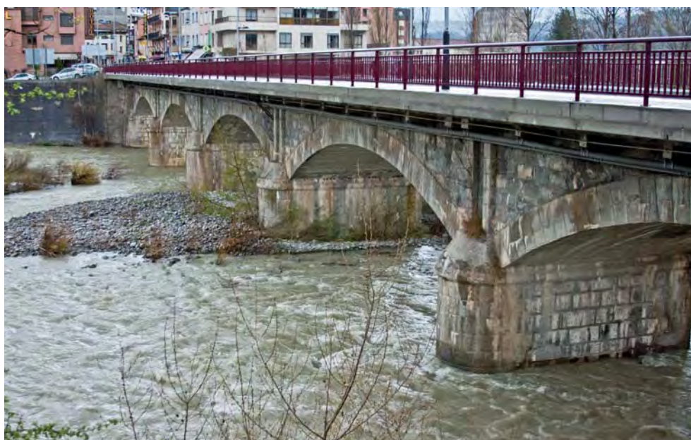
fig. 5. Vista general del puente sobre el río Ara en Ainsa, estado actual (fot. Carlos Colás).
