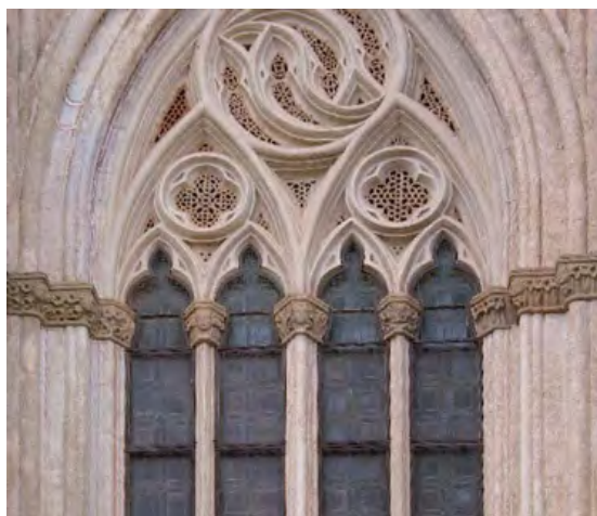
fig. 3. Monasterio de Guadalupe (Cáceres). Detalle de la tracería de la capilla de Santa Ana descubierta en las obras de restauración por el arquitecto Luis Menéndez-Pidal en la mitad del siglo XX. Las ventanas estaban tabicadas y conservaban parte de los elementos compositivos y decorativos. En la restauración el arquitecto repona el mortero de recubrimiento siguiendo el modelo de construir en Guadalupe.
