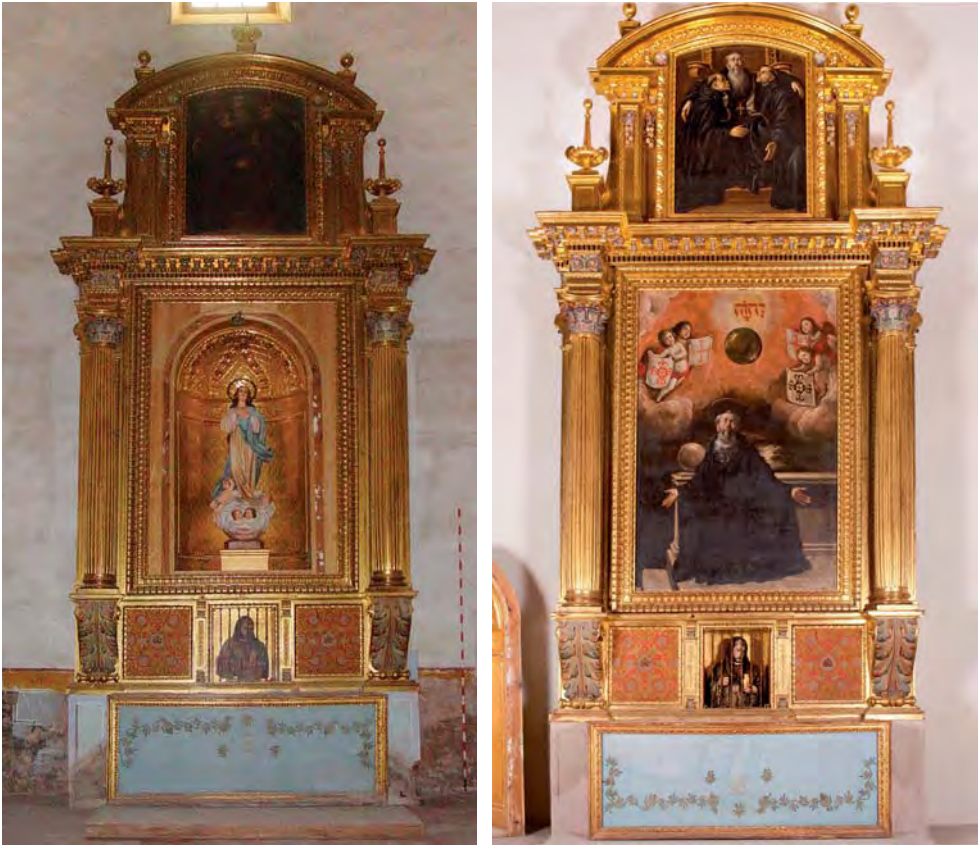
fig. 5. Retablo de San Benito de la iglesia del monasterio de San Millán de la Cogolla, de Yuso, antes (izq.) y después (dcha.) de la restauración de 2007-2010 (fots. O. Reinares, 2006, y Artempus, 2011).
