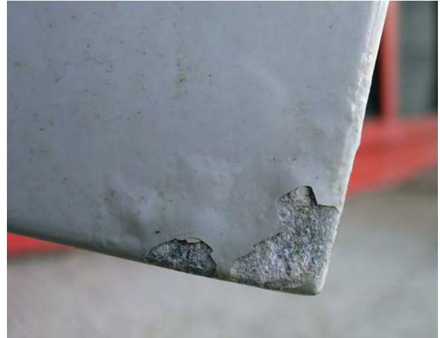
Figure 12 Pulverulent corrosion under the paint bubbles on the Boisseau sculpture. Lise Boisseau, Miroirs, ronds de lumière et rideau de scène , 1996 (detail). © Lise Boisseau. Photo: Nathalie Richard, 2012 © CCQ.
