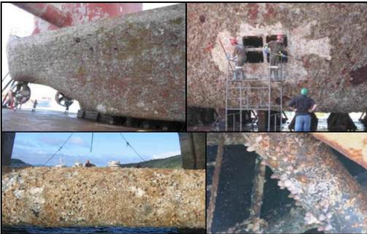
Figura 2. Incrustações em embarcações e suas estruturas. Fotos: arquivo pessoal.
