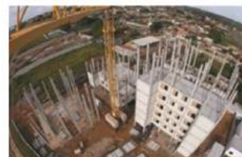
Figura 4: Sistema construtivo em pré-fabricados em concreto aplicados no segmento habitacional (Font: ABCIC)
