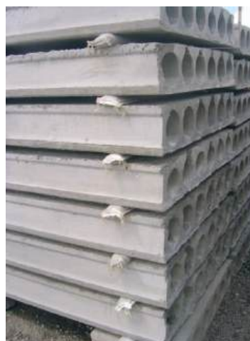
Figura 82: Situações transitórias: armazenamento de lajes alveolares pré-fabricadas
