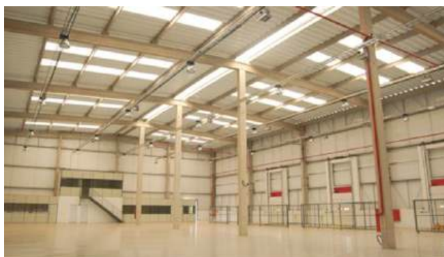
Figura 80: Cobertura com telhas metálicas para vãos menores
