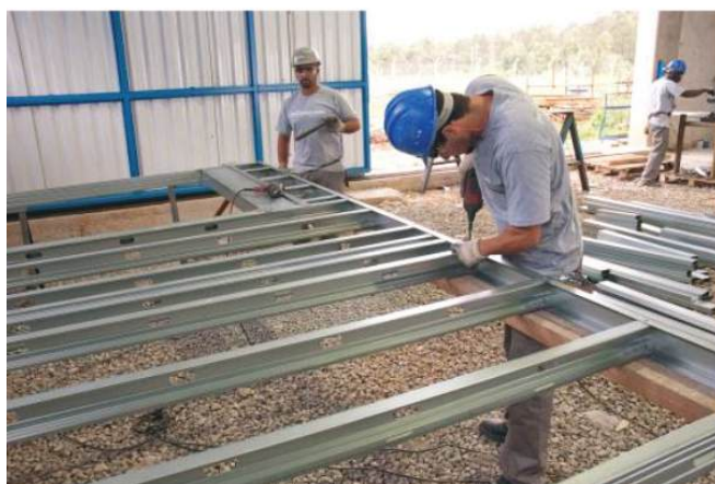
Figura 50: Sistema de painéis (Fonte: Construtora Micura)
