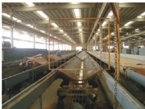
Figura 79: Fábrica de estruturas pré-fabricadas de concreto, com cobertura em telhas W com domos, em produção das telhas W (pistas)
