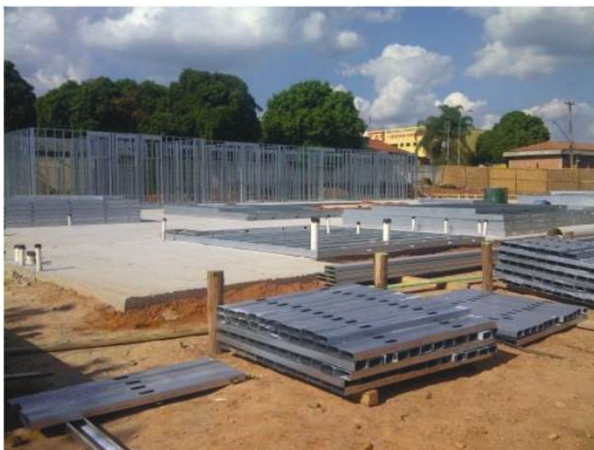
Figura 49: Sistema stick (Fonte: Saint-Gobain)
