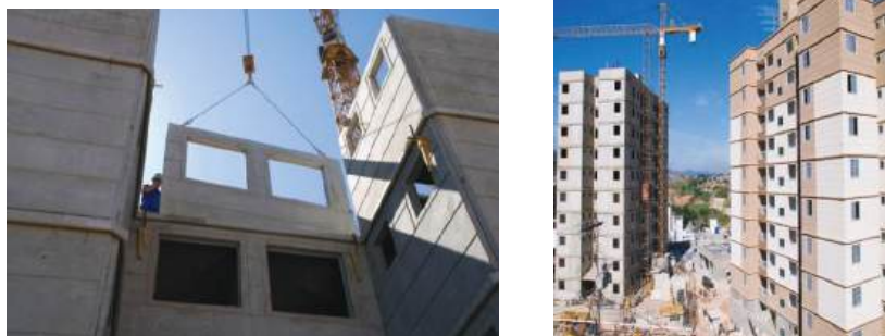
Figura 76: Montagem de painéis em edifício residencial – Condomínio Piemonte, em 2008 – Belo Horizonte (MG)
