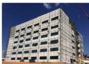
Figura 46: Fachada em light steel framing com vedação em Placas Cimentícias (Fonte: Saint-Gobain)
