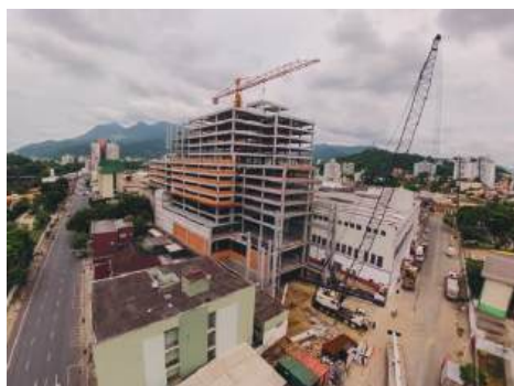
Figura 65: Shopping em Jaraguá do Sul (SC) em ampliação com torre que abrigará um hotel (exemplo de estrutura em esqueleto)
