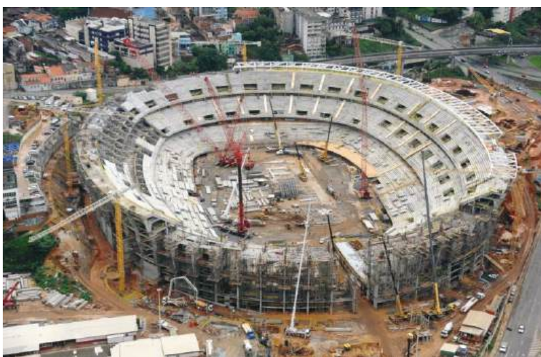
Figura 63: Estádio Arena Fonte Nova durante a montagem da estrutura pré-moldada
