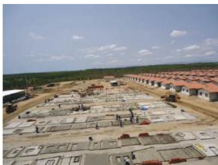
Figura 99: Processo de fabricação no canteiro de obras. (Fonte: Olé Casas, 2015)
