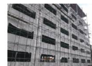
Figura 45: Fachada em light steel framing com vedação em Placas Cimentícias (Fonte: Saint-Gobain)
