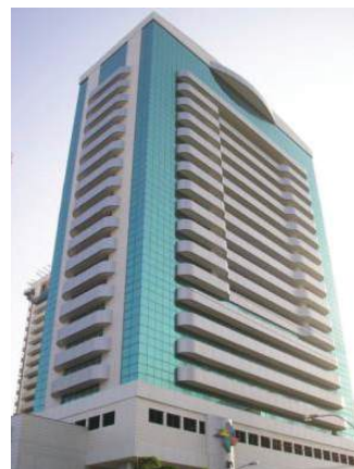
Figura 72: Empreendimento Pátio Dom Luís em Fortaleza (CE), composta de vigas e lajes pré-fabricadas protendidas e pilares moldados no local e torres de 20 e 24 pavimentos
