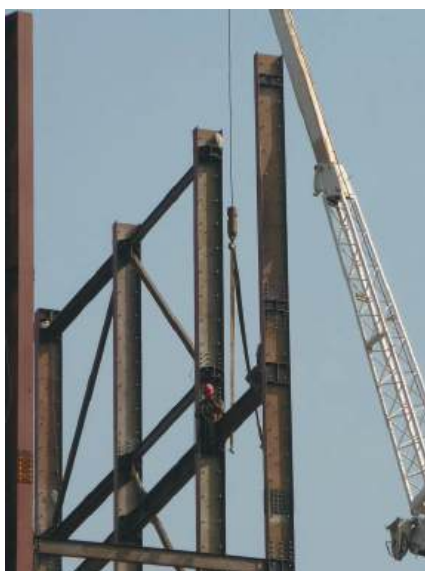
Figura 37: Montagem da estrutura de aço (Imagem: arquivo CBCA)
