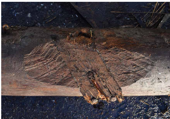
Afbeelding 55. Een lipverbinding van een zwing, aangebracht op het moment dat het rondhout onderdeel is geworden van het vierkant van de boerderij. Op de plek van de houtverbinding is het rondhout afgeplat.
