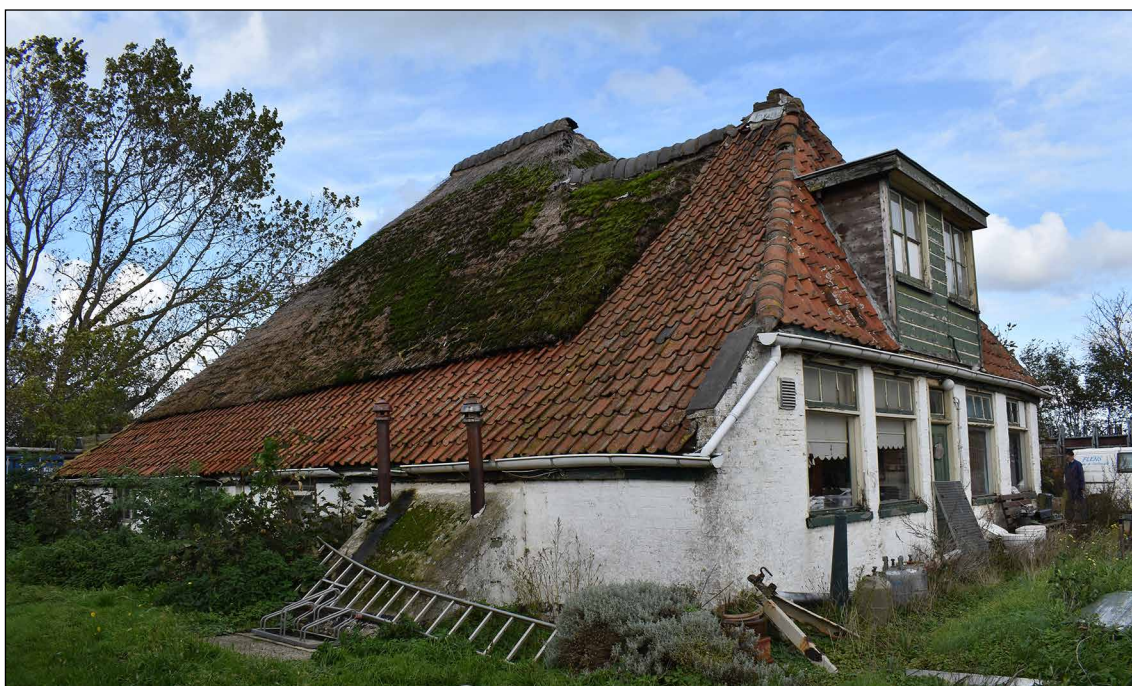
Afbeelding 18. De westelijke zijgevel en het voorhuis.
