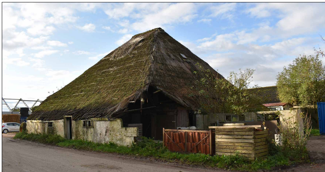
Afbeelding 15. De oostelijke zijgevel en achtergevel van de boerderij.
