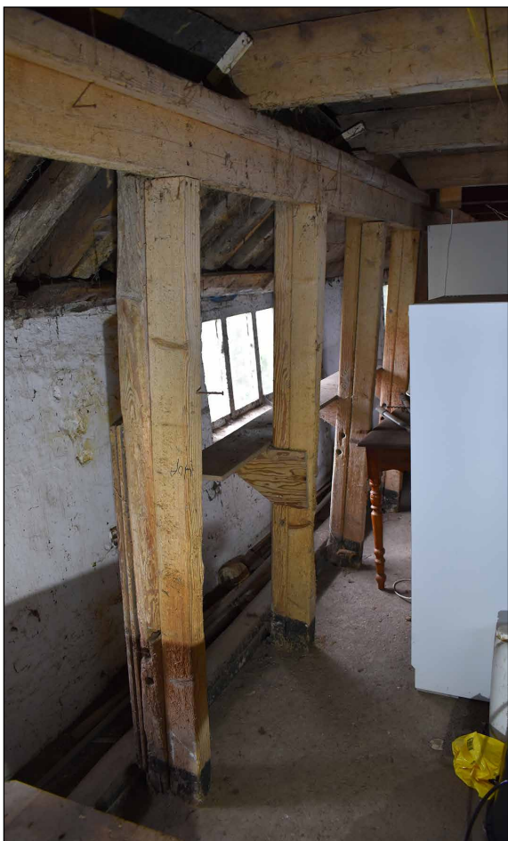
Afbeelding 27. Houten stijlen in de koeienstal.
