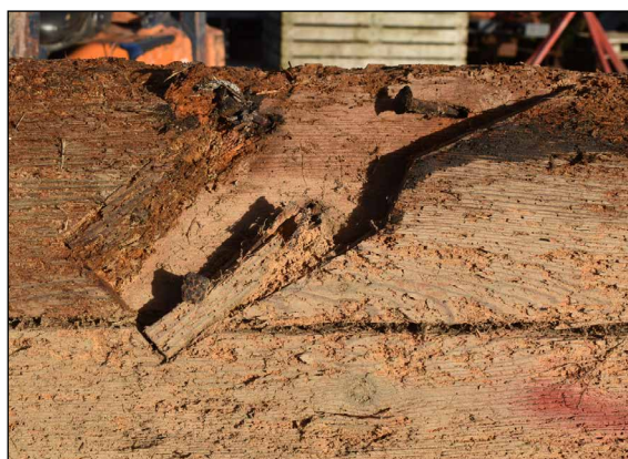
Afbeelding 69. Twee lipverbindingen met hak. Links op de oostelijke bovenbalk, boven op een stijl.
