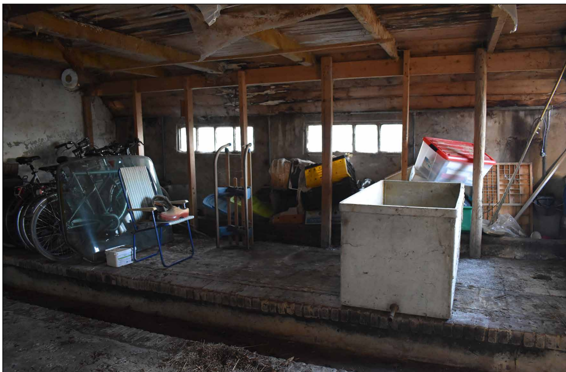
Afbeelding 30. De koeienstal aan de achterkant van de boerderij, gezien richting de achtergevel.
