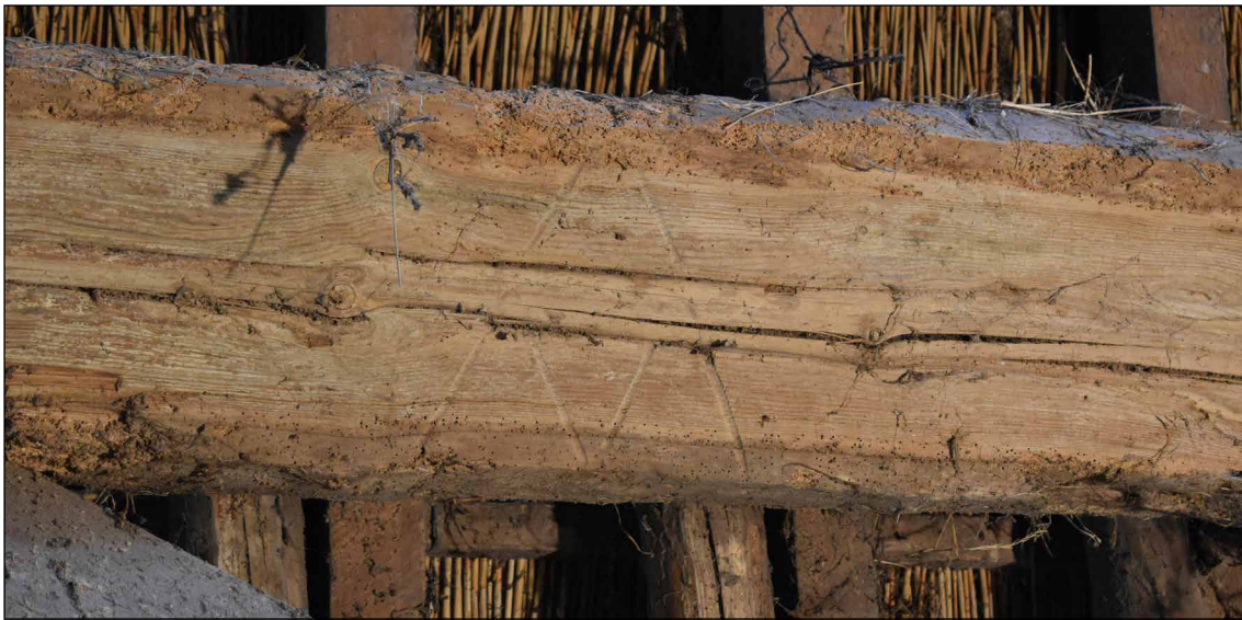
Afbeelding 66. Een handelsmerk op de onderkant van de oostelijke bovenbalk.
