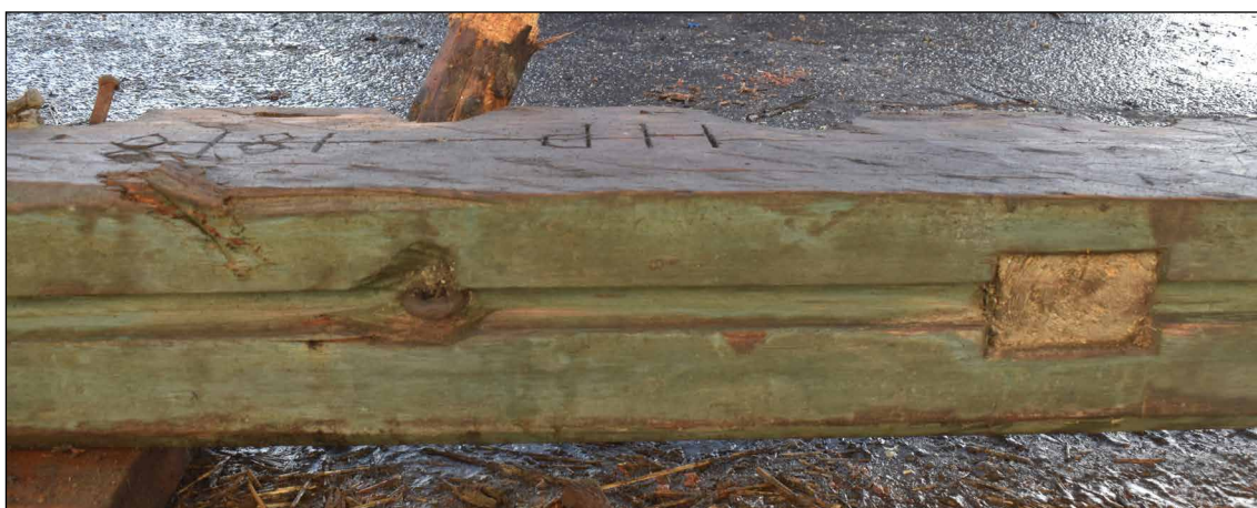
Afbeelding 59. Rechthoekig deel van het rondhout met het ijzeren oog (links) en een balkje die dwars door het rondhout gaat (rechts).
