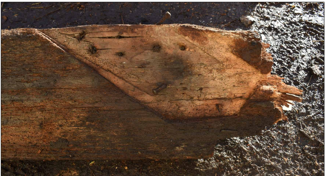
Afbeelding 72. Lipverbinding zonder hak op stijl 2. Binnen deze verbinding is vaag de originele lipverbinding met hak zichtbaar.
