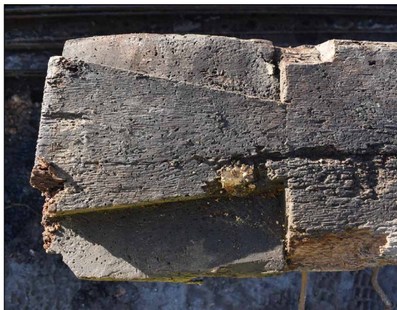
Afbeelding 49. Een voorloef op de bovenkant van een van de dekbalken.
