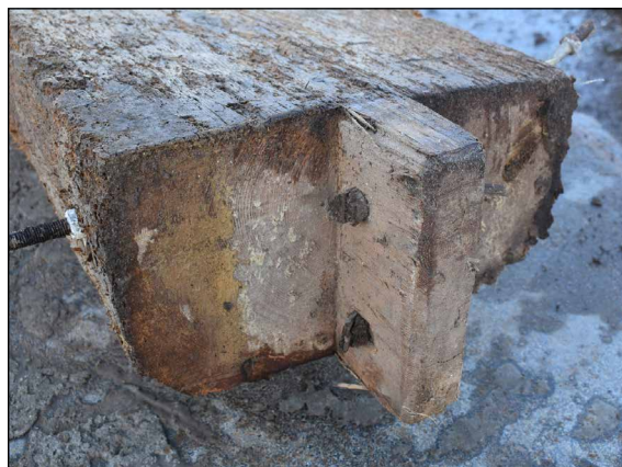
Afbeelding 46. Bovenzijde van een stijl met een pen en twee toognagels.
