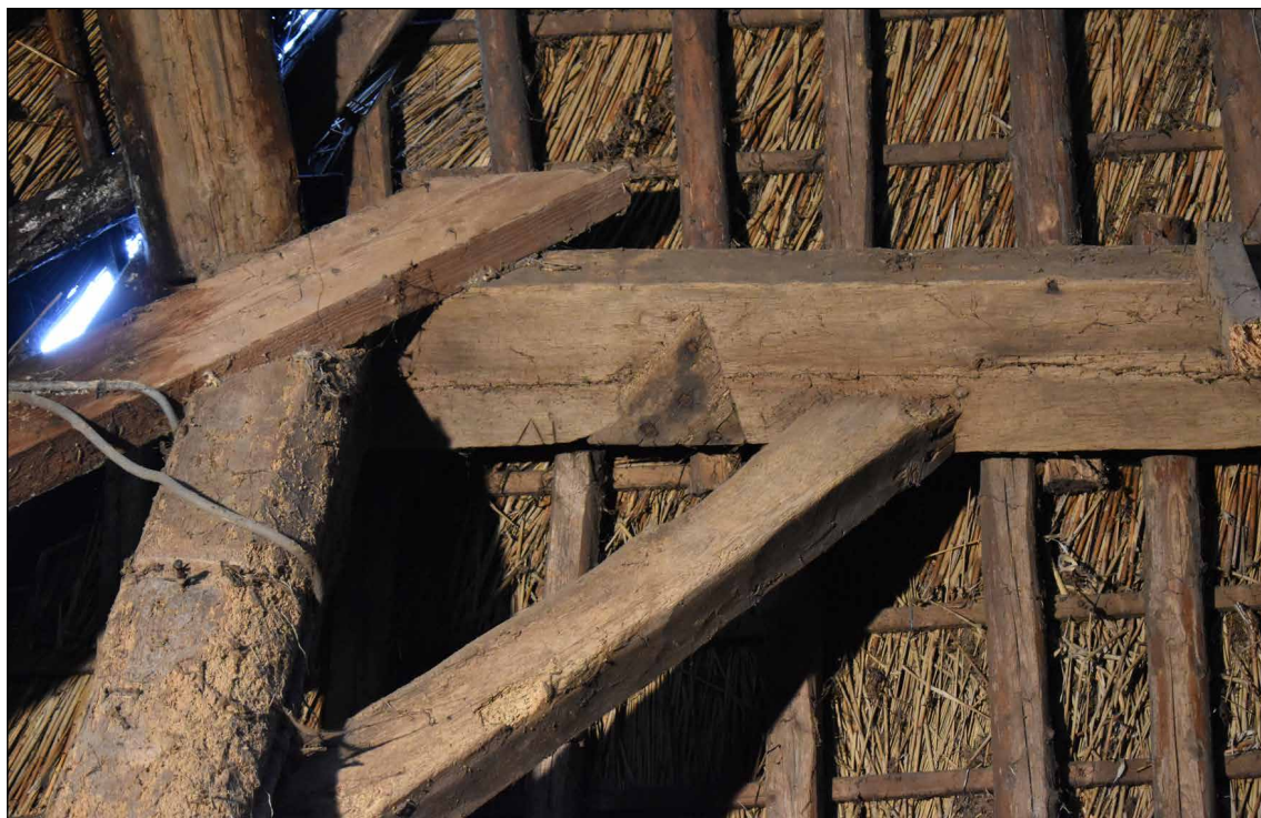
Afbeelding 44. Afgezaagde lipverbinding op de onderkant van de zuidelijke dekbalk (oostzijde). Links daarvan een telmerk: IV.
