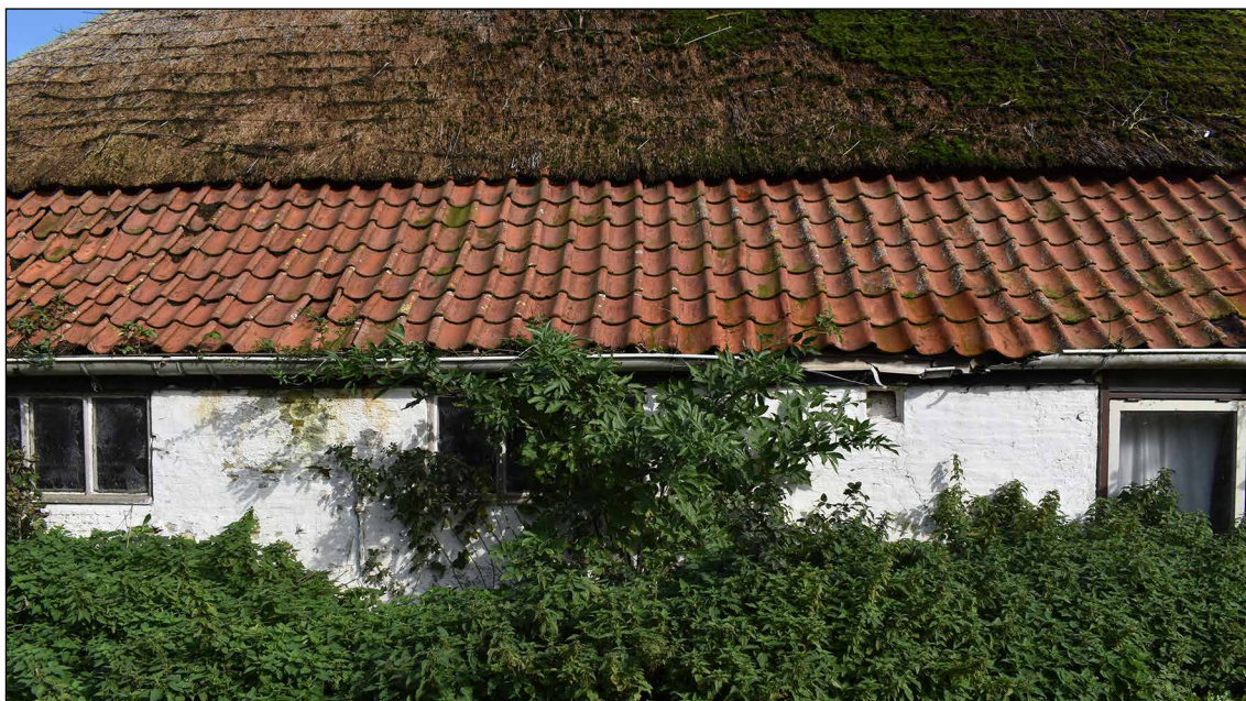
Afbeelding 20. Deel van de westgevel met enkele ramen. Van links naar rechts: twee betonnen stalramen, een klein raampje zonder kozijn en een modern raam van de slaapkamer.
