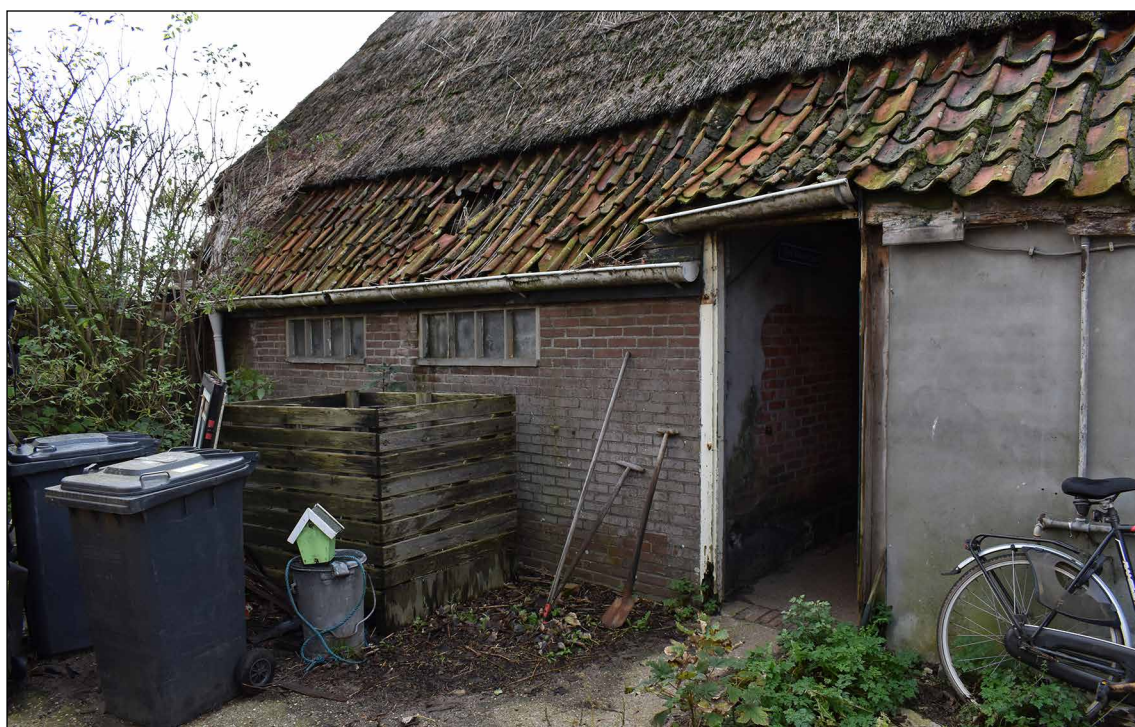
Afbeelding 22. Deel van de achtergevel met de toegang naar de koeienstal.
