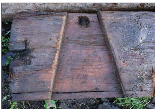
Afbeelding 50. Een loef op de onderkant van de oostelijke bovenbalk.
