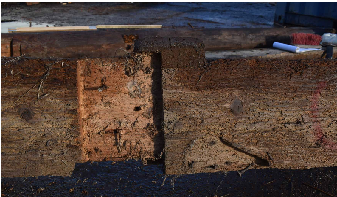
Afbeelding 67. Een inkeping op een stijl van een draagbalk.
