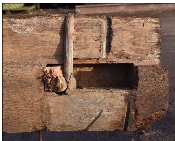
Afbeelding 47. Pengat in de onderzijde van de zuidelijke dekbalk, met twee toognagels.
