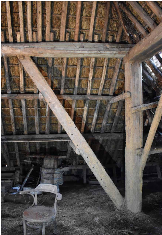
Afbeelding 70. Een zwing van hergebruikt hout.
