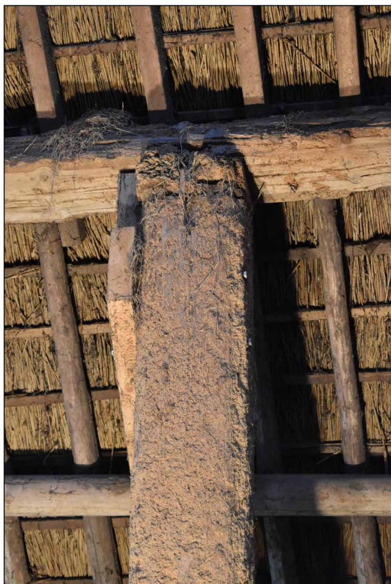
Afbeelding 43. Bovenzijde van de middelste stijl aan de oostzijde, met daarop een restant van de verdwenen dekbalk.
