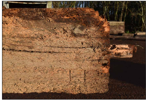
Afbeelding 64. Telmerk II op de bovenkant van stijl 4.
