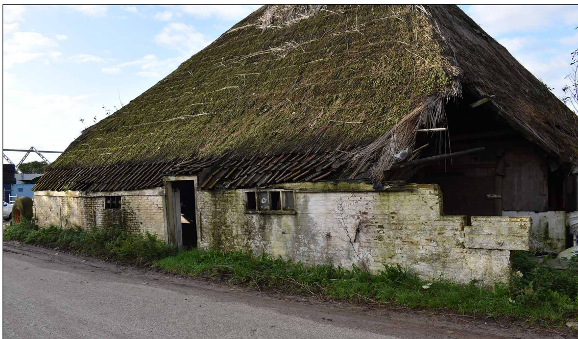
Afbeelding 17. De oostelijke zijgevel.
