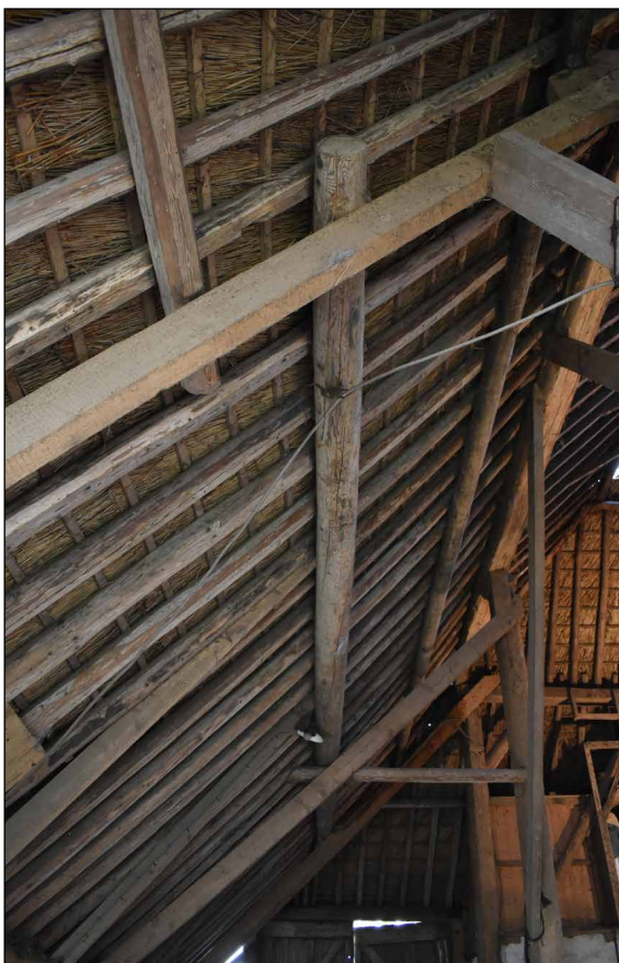
Afbeelding 73. Hergebruikt rondhout van een schip tegen de kap.
