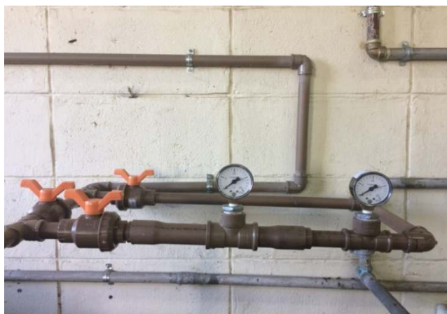
(Figura 9- Tubo de Venturi)
