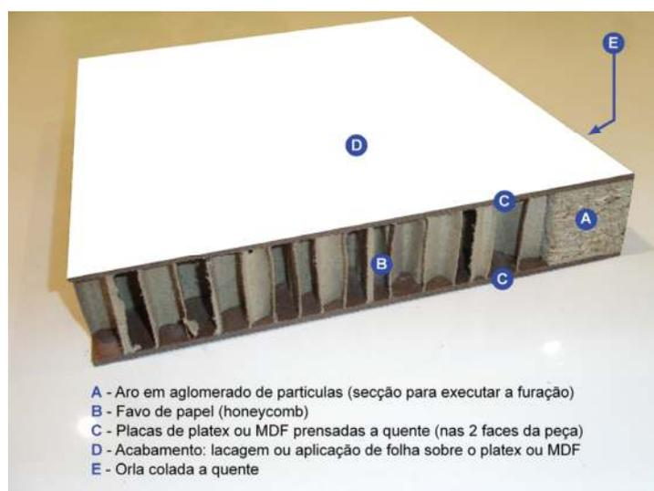
Figura 35 – Construção de peça em corte <sup>53</sup>
