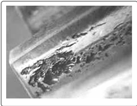
Figura I-12 Imagen tomada utilizando la técnica del ensayo no destructivo: Videoscopia
