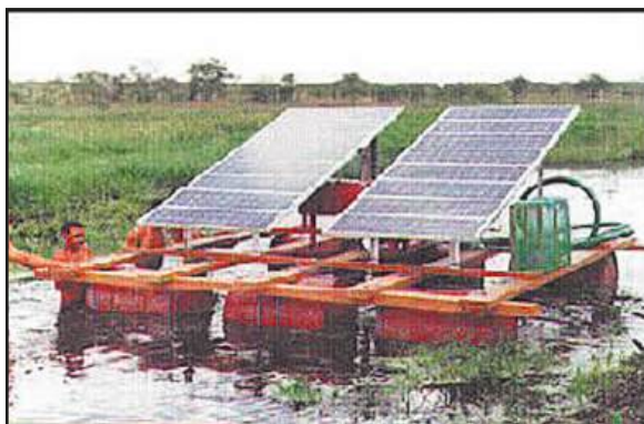
Figura 1.11 Sistema fotovoltaico de bombeamento de água para irrigação (CRESESB, 2000)
