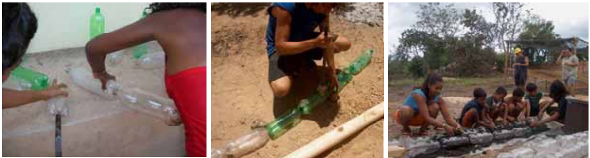
Foramento e conexão das garrafas e seus enchimento com o substrato
