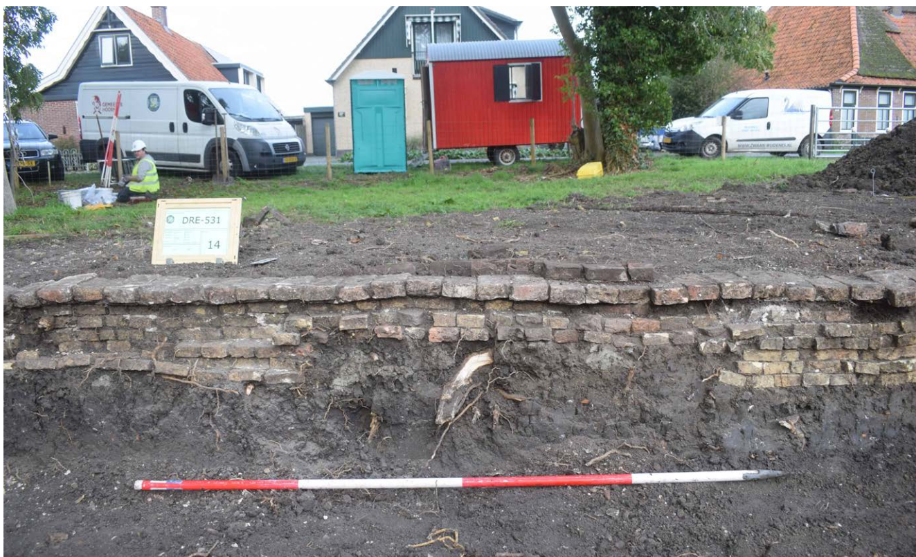
Afb. 52. Zijaanzicht van het midden van fundering S8, waar op de plek van een deur ondieper was gefundeerd.
