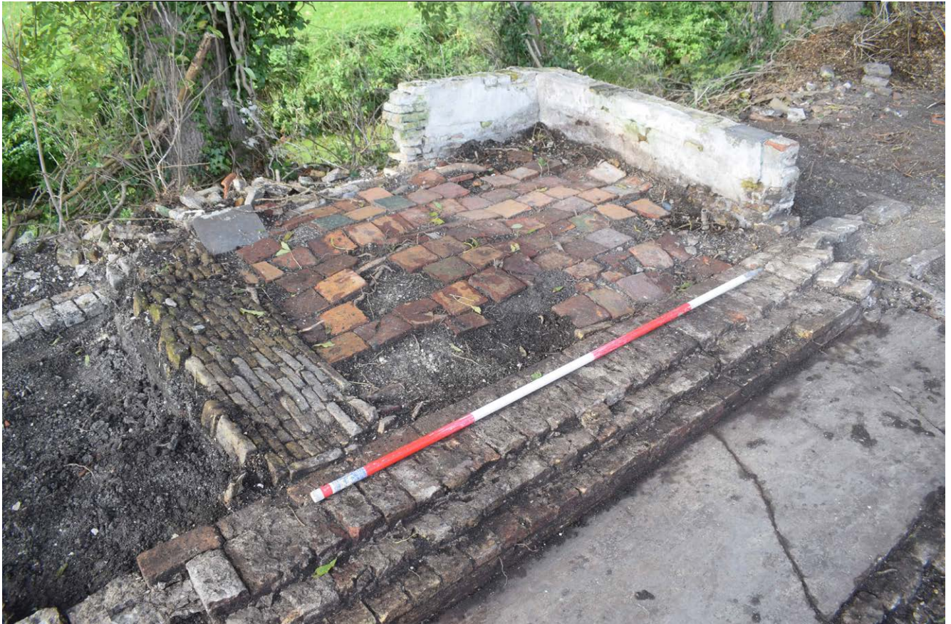
Afb. 49. De noordwestelijke hoek van de koeienstal, waar nog opgaand muurwerk aanwezig was (S35). Binnen de stal plavuizen (S34) en een klinkerbestrating (S36).
