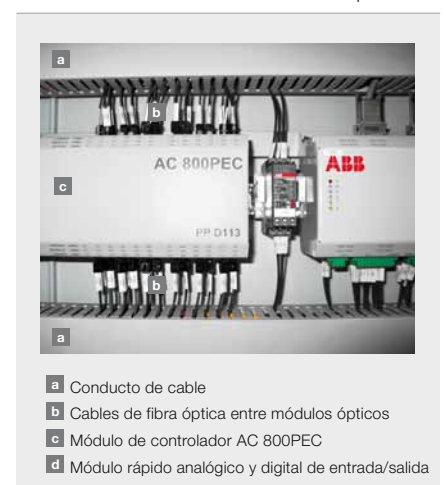
8 Controlador de convertidor de energía AC800 PEC con enlaces de fibra óptica
