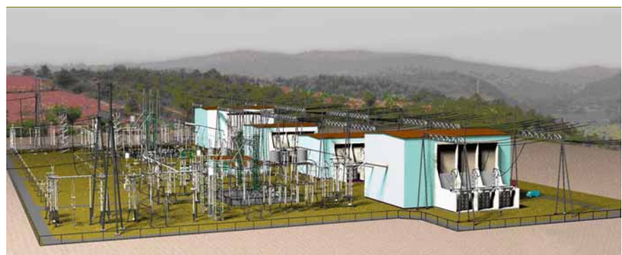
Imagen de una estación convertidora de 800 kV generada por ordenador
