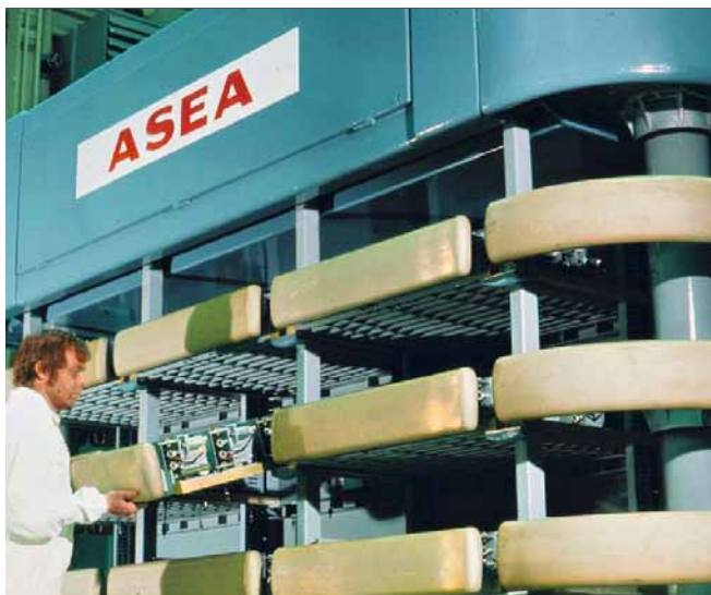
Uno de los primeros convertidores de HVDC basados en tiristores de ASEA
