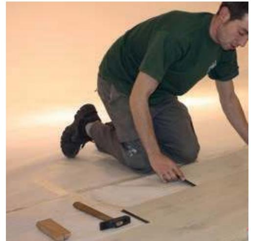
**👉 | La instalación de revestimientos** tiene que considerar parámetros como: la anchura entre juntas, la horizontalidad en el caso de suelos y techos o la verticalidad caso de paredes
