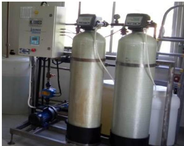
**Figura 1.** Sistema Deionizador. Fonte: autor (2017).
