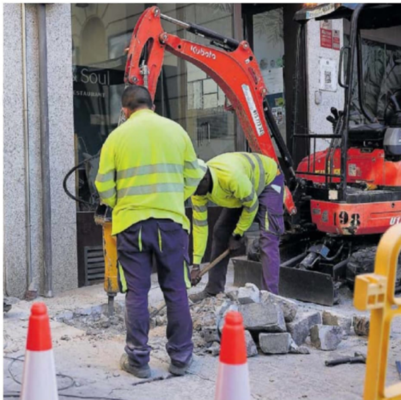
Trabajadores en unas obras en Toledo, ayer. ISMAEL HERRERO (EFE)
