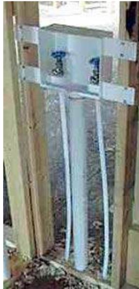
A tubulação é colocada em seu lugar e preenchida. Note o problema com as estruturas sendo corrigidas no lado esquerdo da tubulação, pois ela mudou de tamanho:
