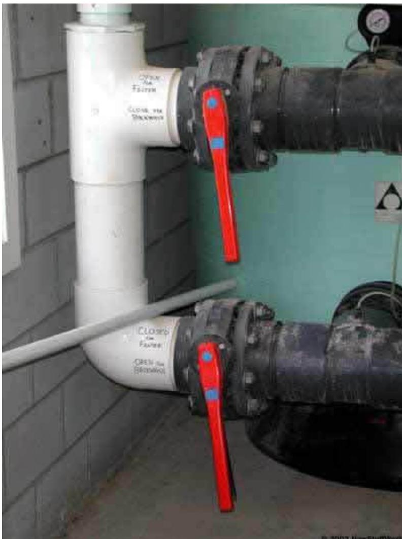
**Para redirecionar o fluxo de água para lavagem, é necessário girar grandes alças para ajustar as válvulas de bombeamento**
