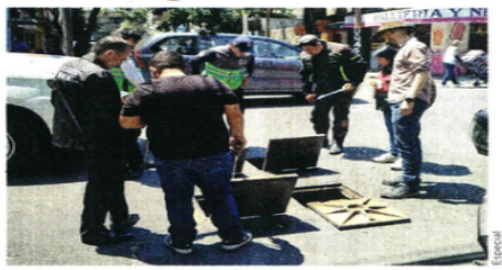
Además del análisis de la calidad de agua, se realiza desazolve del drenaje.
