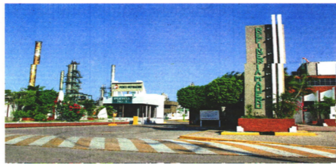
La refinería de Petróleos Mexicanos de Ciudad Madero, en el estado de Tamaulipas, es la que tiene la mayor plantilla laboral, al contar con 4 mil 131 trabajadores.
