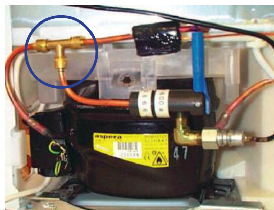
Figura 54. Ejemplos de uniones con unión en frío o tipo Lokring en T
