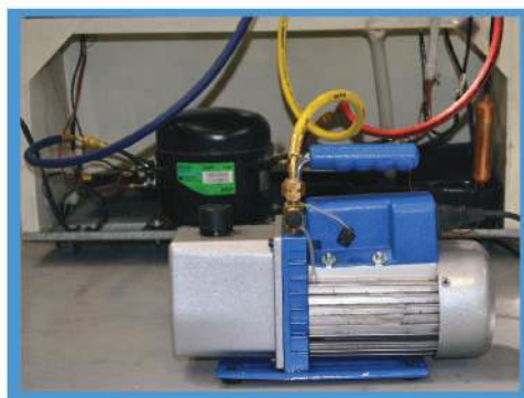
Figura 58. Conexión de la bomba de vacío al sistema
