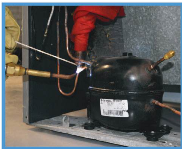
Figura 52. Instalación filtro secador nuevo.
