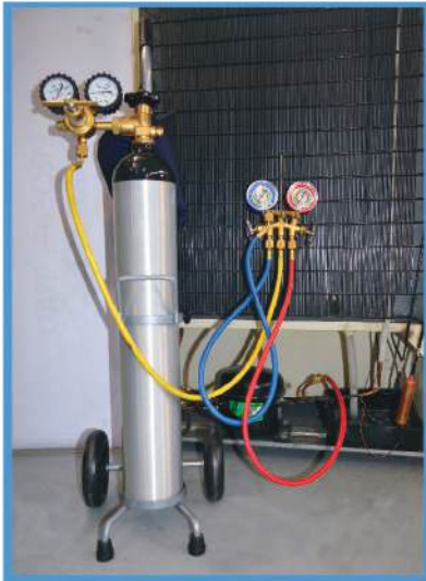
Figura 56. Carga del sistema con nitrógeno.
