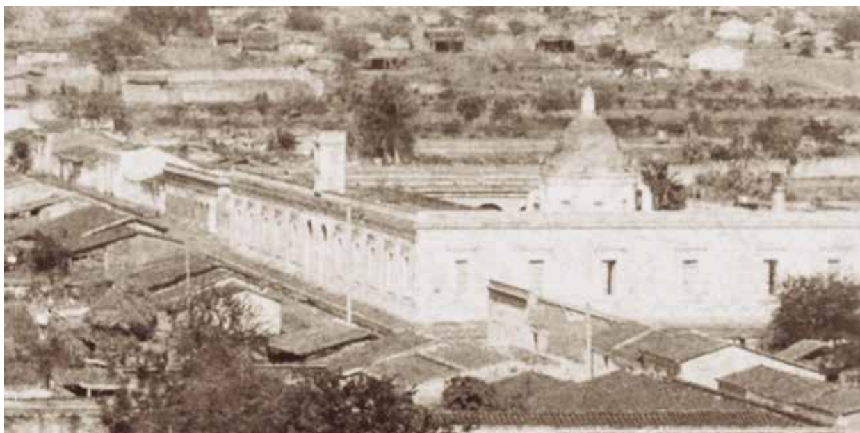
Imagen 24. Hospital del Carmen en Culiacán
