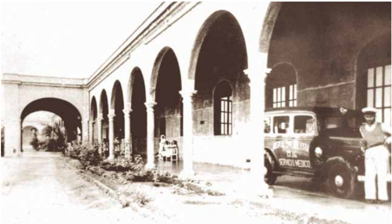
Imagen 26. Hospital Civil de Culiacán en los años treinta
