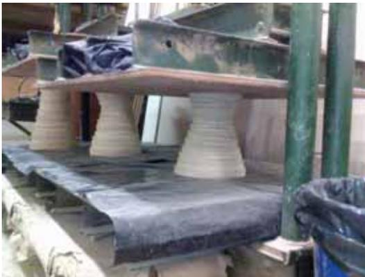
Figura 88. Prensagem dos laminados da banqueta Carretel
