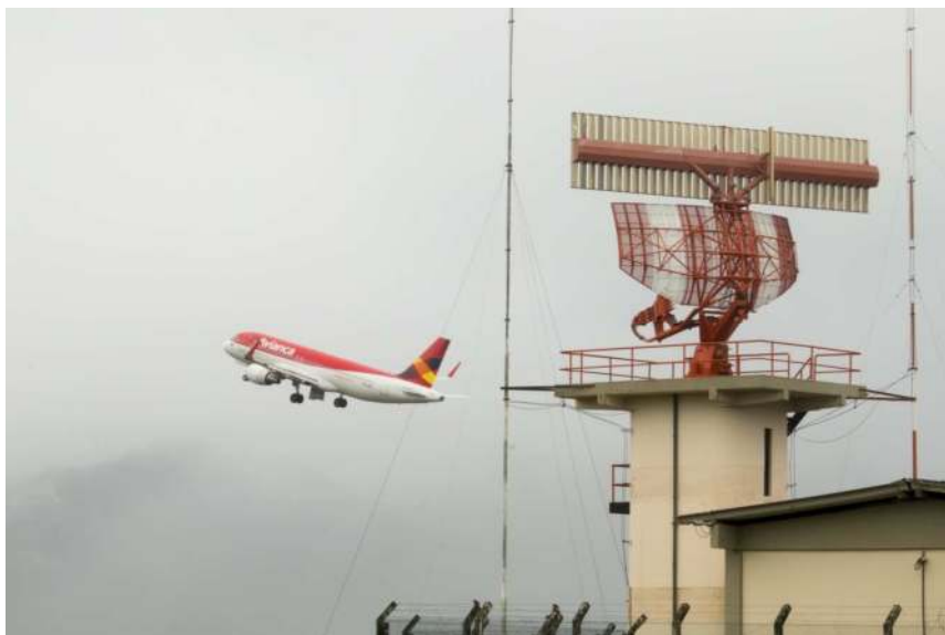
Tipo de Antena de Radar Primário (abaixo), associado ao Secundário (em cima).
