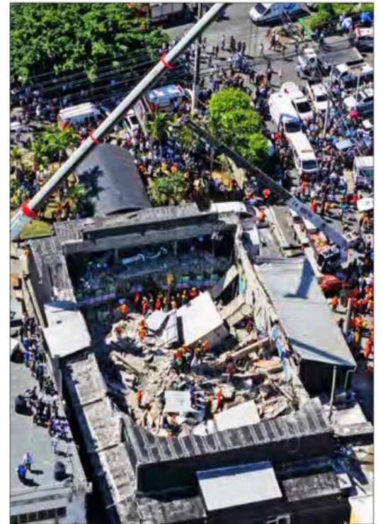
▲ El techo de un icónico club nocturno en República Dominicana colapsó la madrugada de ayer durante un concierto de merengue y dejó un
