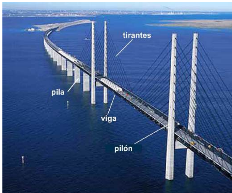
Fig. 1.5: Elementos estructurales básicos
