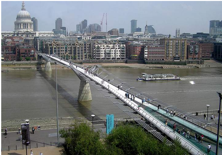
FIGURA 15.33 Al principio, cuando la gente cruzaba la pasarela London Millennium experimentaba un movimiento de vaivén. El hecho de que las personas sigan cruzando reforzó la amplitud de la oscilación, lo que aumentó el problemático vaivén (créditos: Adrian Pingstone/Wikimedia Commons).
