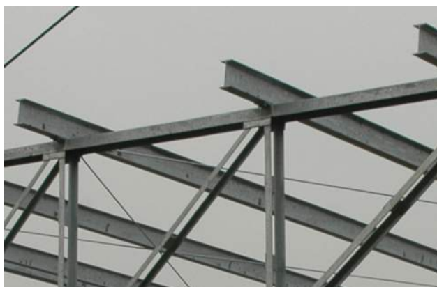
FIGURA 12.21 Las vigas en I de acero se utilizan en la construcción para reducir las tensiones de flexión (créditos: modificación de la obra por "US Army Corps of Engineers Europe District"/Flickr).
