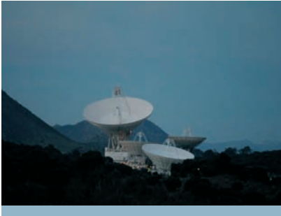
Estación de seguimiento de Satélites de Robledo de Chavela. De las cuatro antenas que aparecen en la imagen, la mayor es la DSS-63, de 70 m de diámetro, y las otras tres de 34 m son la DSS-61 (la antena de PARTNeR), la DSS-65 y la DSS-55. Créditos: Alejandro Sánchez (Universidad Complutense de Madrid).
