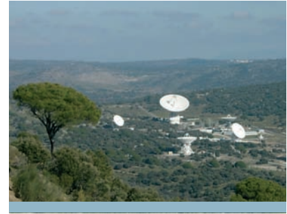
El Centro de Comunicaciones de Espacio Profundo de Madrid, localizado en Robledo de Chavela (a 40 km de Madrid), es una de las tres estaciones de seguimiento que componen la Deep Space Network (DSN) de NASA, JPL. Créditos: Luis F. Rojo (MDSCC), Juan Ángel Vaquerizo (Centro de Astrobiología).
