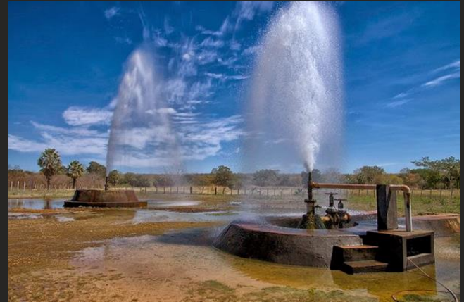
Fig. 5 - Poço Violeta - Poço jorrante com 1.500 m de profundidade. Localizado na cidade de Cristiano Castro, sul do estado do Piauí, a 600 km da capital, Teresina. Fonte: < https://www.fundaj.gov.br/index.php/tecnologias-de-convivencia-com-as-secas/8009-poco-violeta-tambem-chamado-violeto-no-municipio-de-cristino-castro-pi > (2018).
