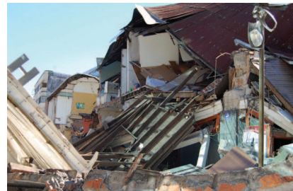
Destruição causada por um sismo na cidade de Concepción, no Chile, em 2010. Este tipo de desastres naturais assume um caráter súbito e compromete a segurança ambiental dos cidadãos.
