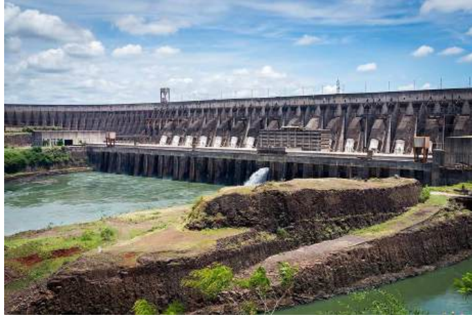
Figura 1.6 - A usina hidrelétrica de Itaipu.
