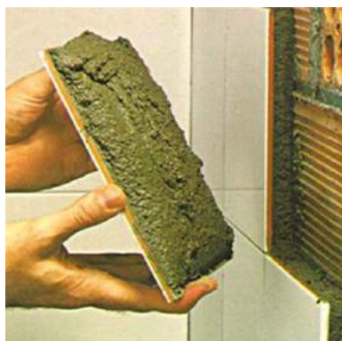
Instalación de azulejo en capa gruesa
