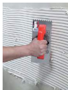
Peinado del cemento cola sobre el soporte
