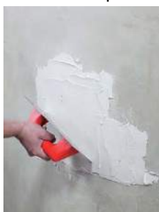
Aplicación del cemento cola sobre soporte
