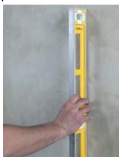
Comprobar la planeidad del soporte
