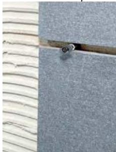
Fijación del anclaje de seguridad
