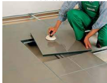
Instalación de los paneles
