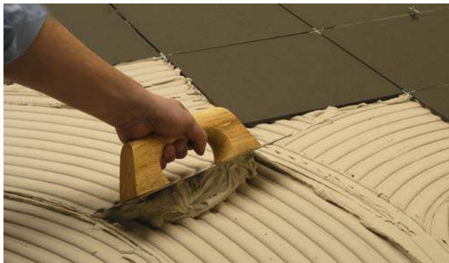
Instalación baldosa cerámica en capa fina
