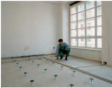
Posicionar los pedestales
