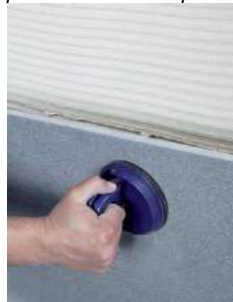
Instalación de la baldosa cerámica
