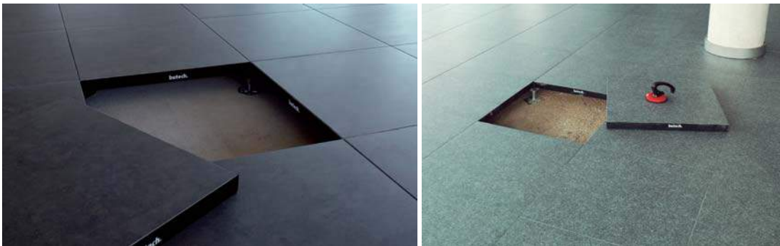
Instalación de suelos técnicos. Butech
