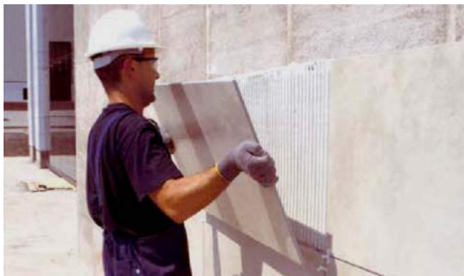
Instalación de fachada aplacada en capa fina
