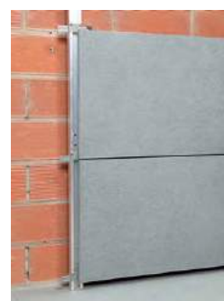
Colocación de hiladas superiores.
