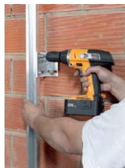
Instalación del perfil vertical sobre la ménsula
