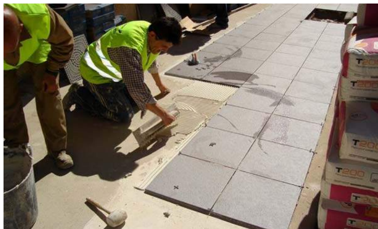
Instalación de acera cerámica. TAU cerámica
