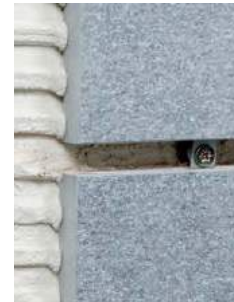
Detalle del sistema de fijación
