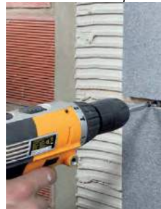
Apriete del anclaje de seguridad
