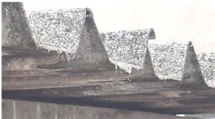
Telha de cimento amianto, onde podemos notar seu desgaste em função de sua textura porosa e deduzir que esta telha já está soltando a fibra mortal do amianto.
