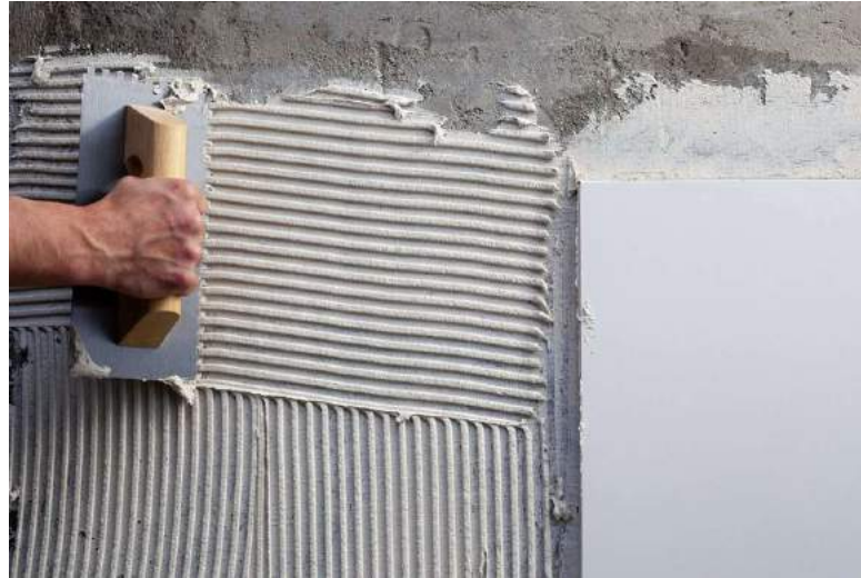
Figura 87 – Aplicação de argamassa colante com desempenadeira dentada.
